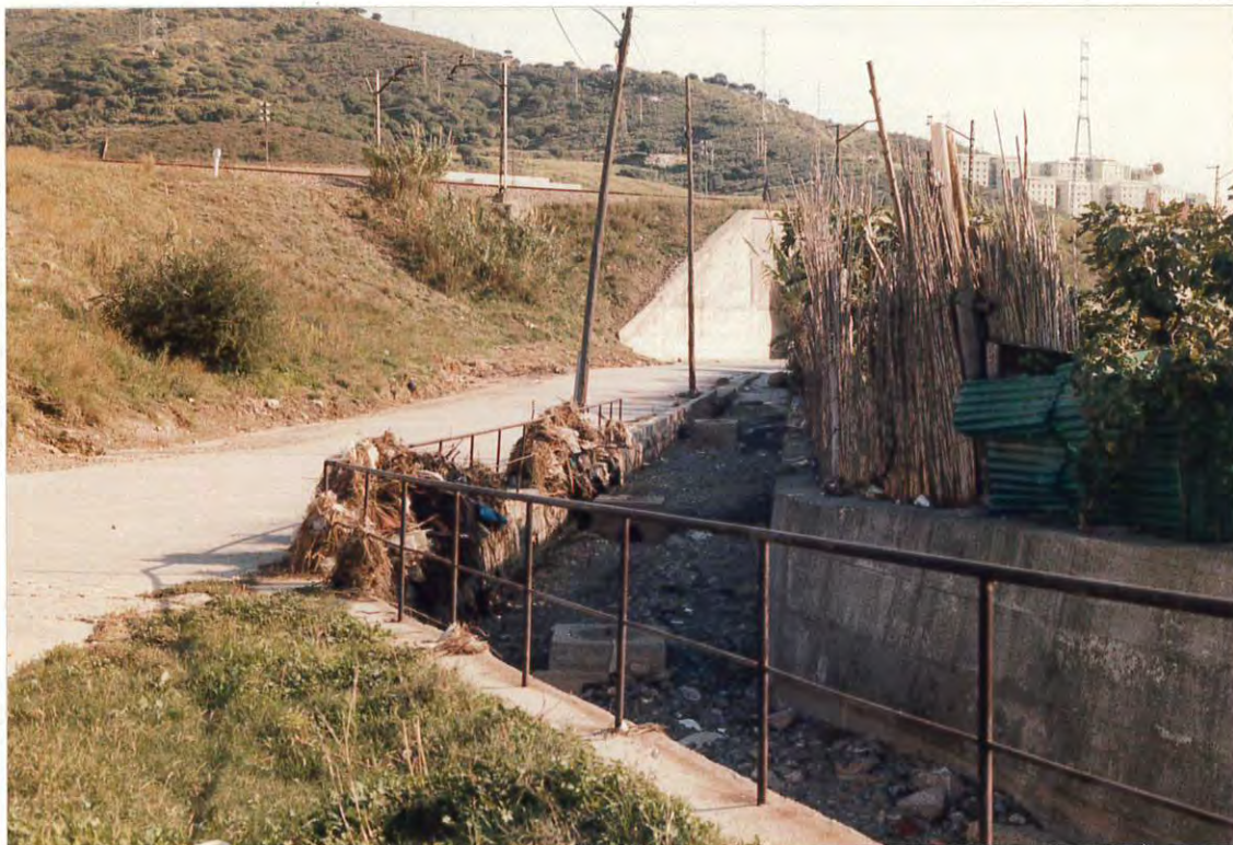
Figura 7. Vista del cauce de la riera Tapioles, donde se aprecian los arrastres acumulados y los obstáculos que representan los pozos de registro existentes en su lecho natural.
