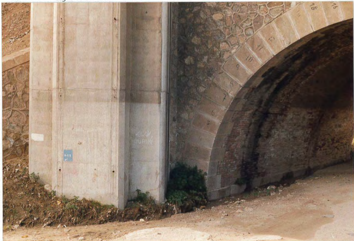
Figura 2. Detalle del puente del ferrocarril y de una pila del puente de la autopista A-17.
