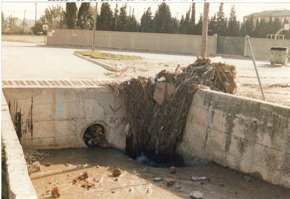
Figura 6. Encauzamiento de la riera Tapioles, donde se aprecia la considerable reducción de sección.
