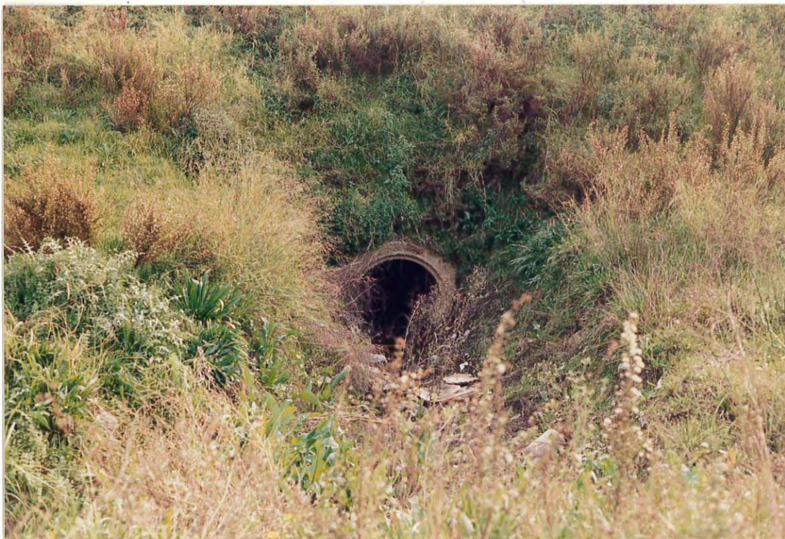
Figura 3. Colector de desagüe de la Rambla La Marina, bajo la Autovía de Castelldefels.
