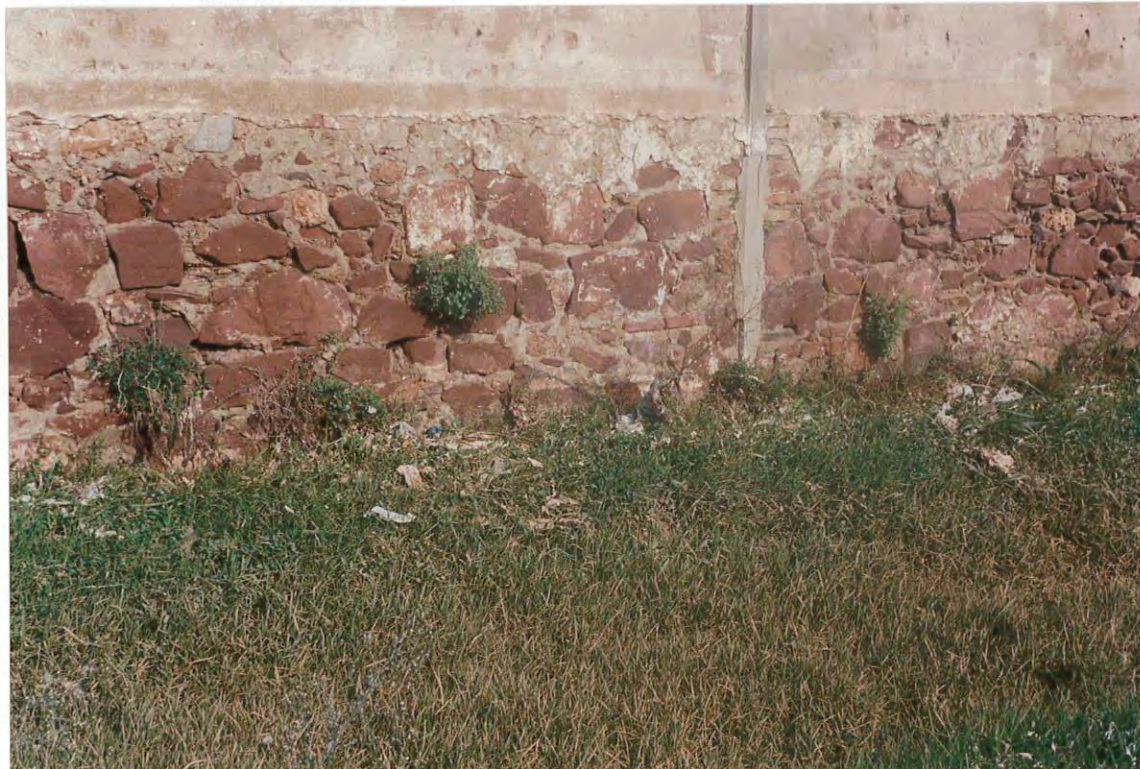
Figura 2. Las aguas alcanzaron un nivel ligeramente superior al de la planta más alta de las que crecen sobre el muro.
