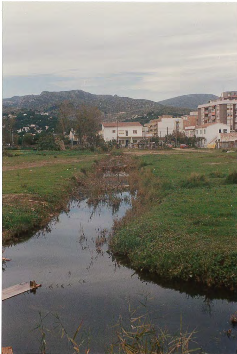
Figura 5. Vista general de un ramal afluente de la Corredera Maestra, en la que puede apreciarse el estado de conservación de su cauce.
