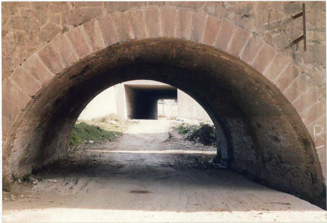
Figura 1. Puente del ferrocarril, donde el agua alcanzó 1,9 m de altura. Al fondo, puente bajo la carretera N-152, donde el agua alcanzó una cota de 30 cm.
