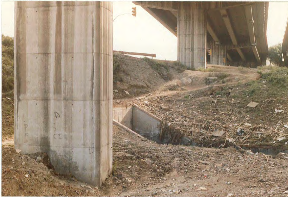
Figura 3. Puente de la autopista A-17, dirección a Gerona. El agua alcanzó 3 m sobre el arranque de la pila, y 4,5 m sobre el lecho de la riera a su paso bajo la carretera N-152.
