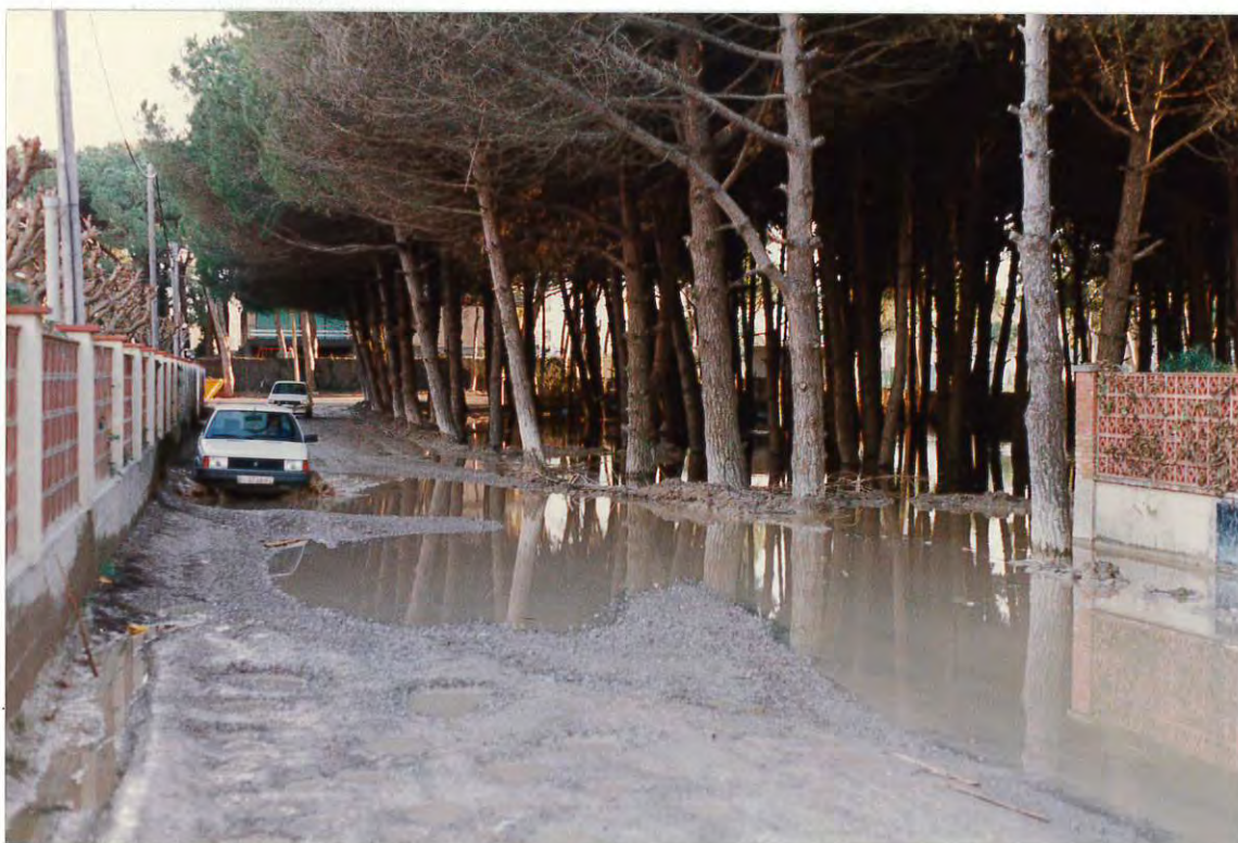
Figura 2. Deterioro experimentado por las calles no pavimentadas, bajo el efecto de los desagües de los sótanos próximos y del ascenso del nivel freático.
