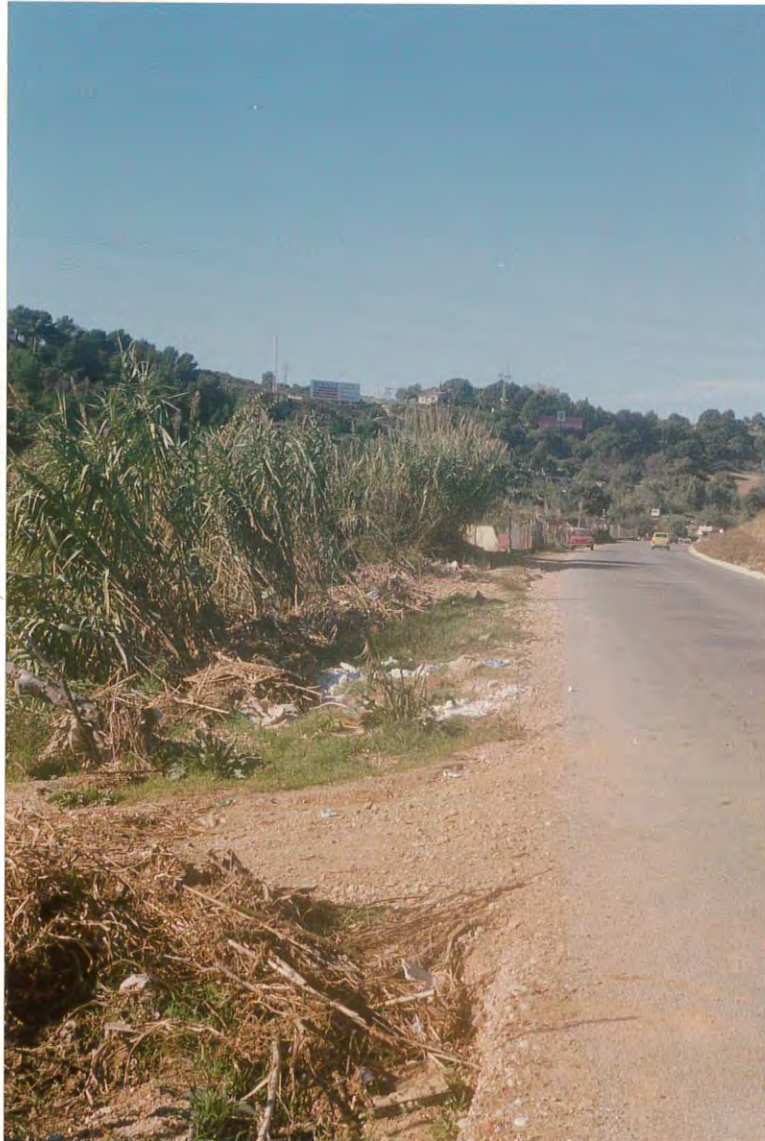
Figura 3. Arrastres acumulados en la cuneta de la carretera de Cerdanyola del Vallès a Ciudad Badia.
