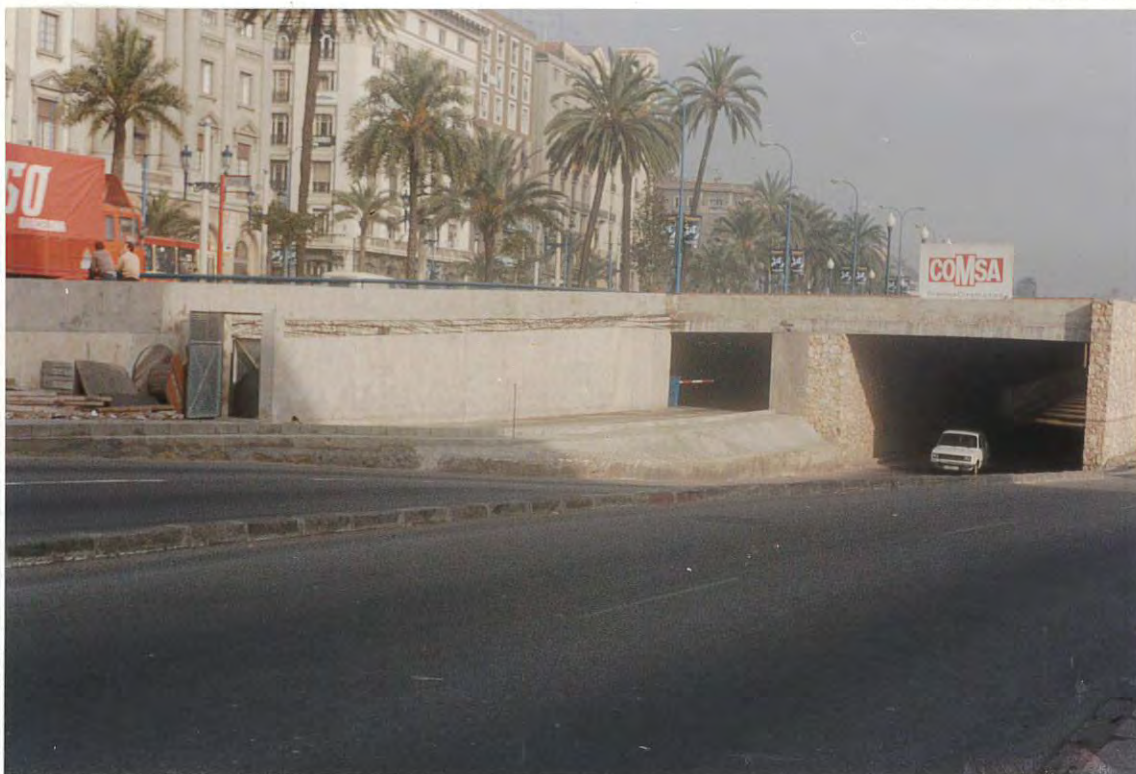
Figura 1. Paso inferior del Moll de la Fusta, visto desde la plaza de Colón. El cambio de color en el centro del terraplén gunitado indica el punto en que reventó el aliviadero.
