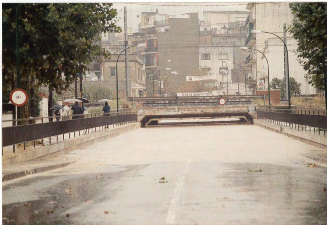
Figura 2. Paso de la avenida de la Pineda bajo el puente del ferrocarril Barcelona-Valencia.
