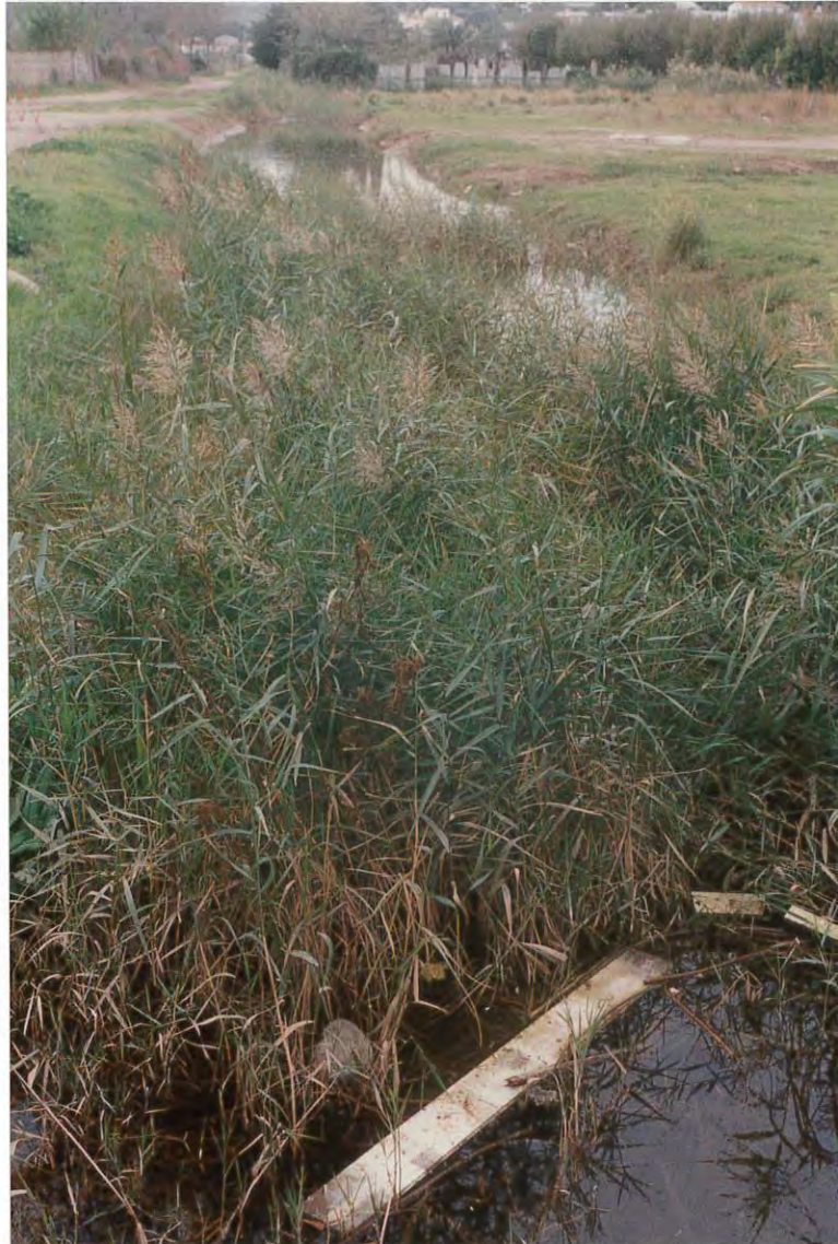
Figura 3. Ejemplo ilustrativo de los considerables obstáculos creados en el cauce de la Corredera Maestra por la acumulación de arrastres y el desarrollo de vegetación.
