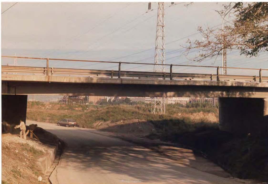
Figura 1. La calle Moratin bajo el puente del ramal de la autopista A-19 en dirección Barcelona.
