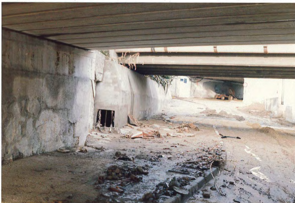
Figura 1. Tareas de limpieza de los arrastres acumulados en el tramo final de la Riera d'en Font.
