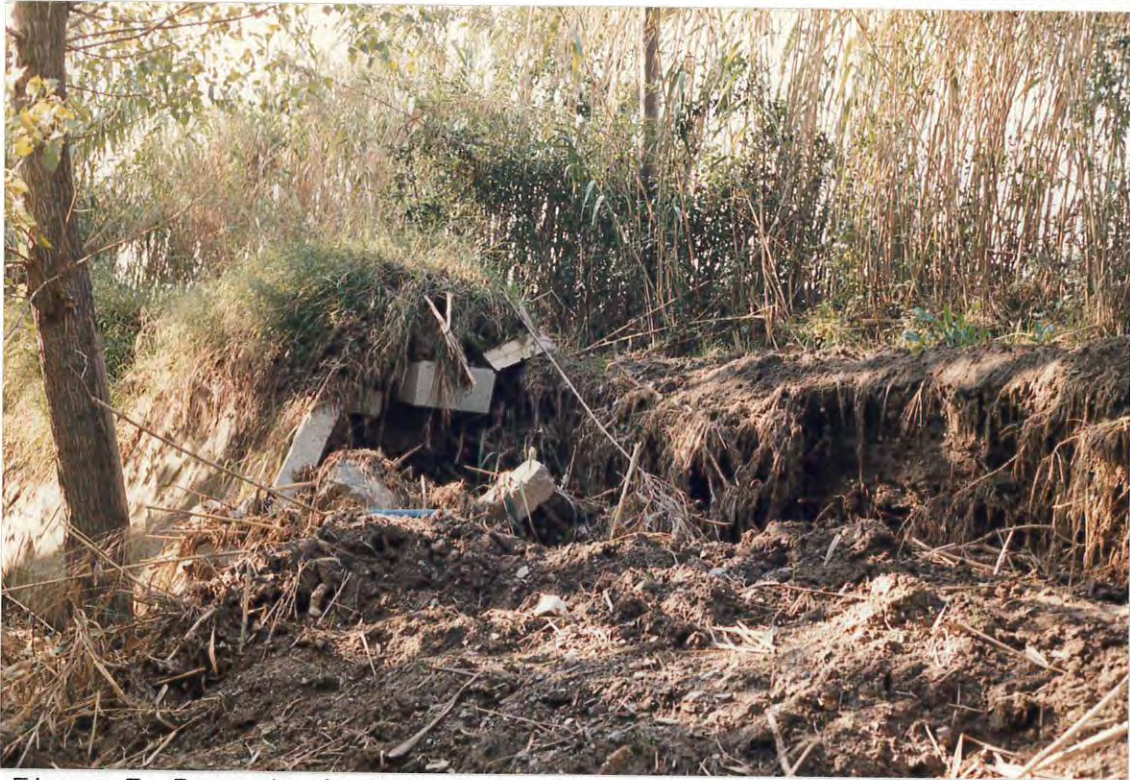
Figura 3. Derrumbamiento y desbordamiento del cauce natural de la riera, aguas abajo de la carretera N-II.
