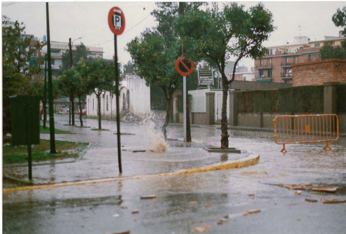
Figura 8. Entrada en carga del colector de la cuenca de la Aviación, durante el episodio de intensas lluvias registrado a mediados de octubre de 1987.
