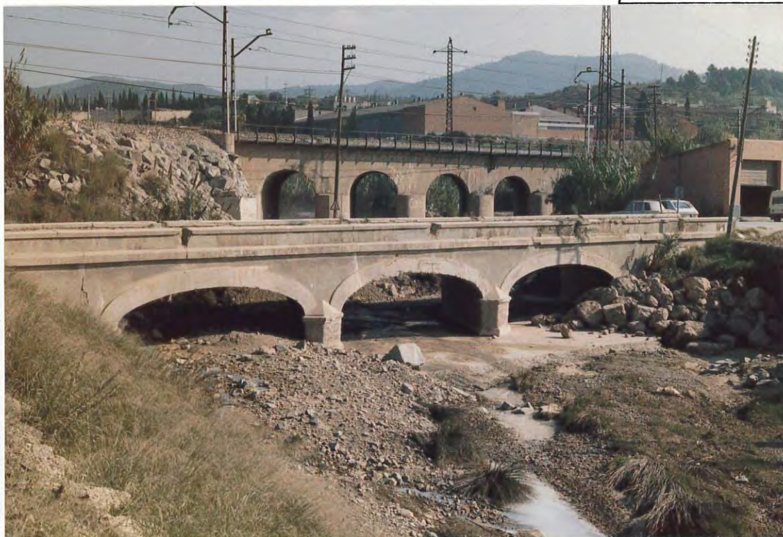
Figura 5. Vista desde aguas abajo de los puentes del ferrocarril y de la carretera de Caldes de Montbui a Molins de Rei. El vano izquierdo ha quedado prácticamente suprimido.
