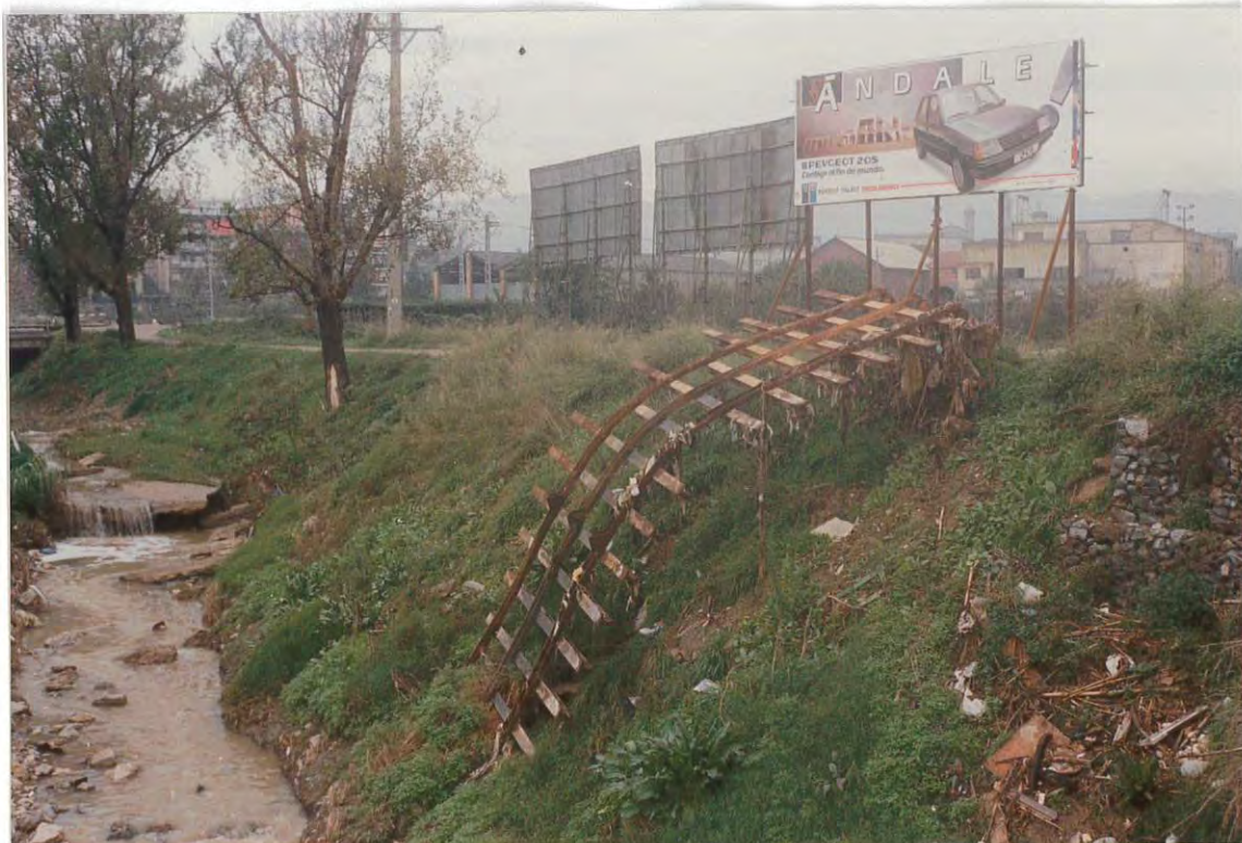
Figura 4. Posición actual de la reja de protección de las clapetas de desagüe de la riera Bertrán al río Llobregat.
