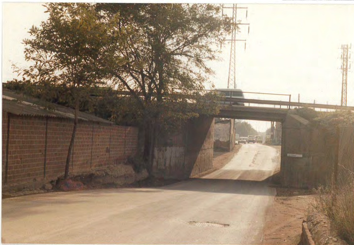
Figura 3. Ausencia de desagüe en la calle Moratín, a su paso bajo el puente del ramal de la autopista A-19 en dirección Mataró.
