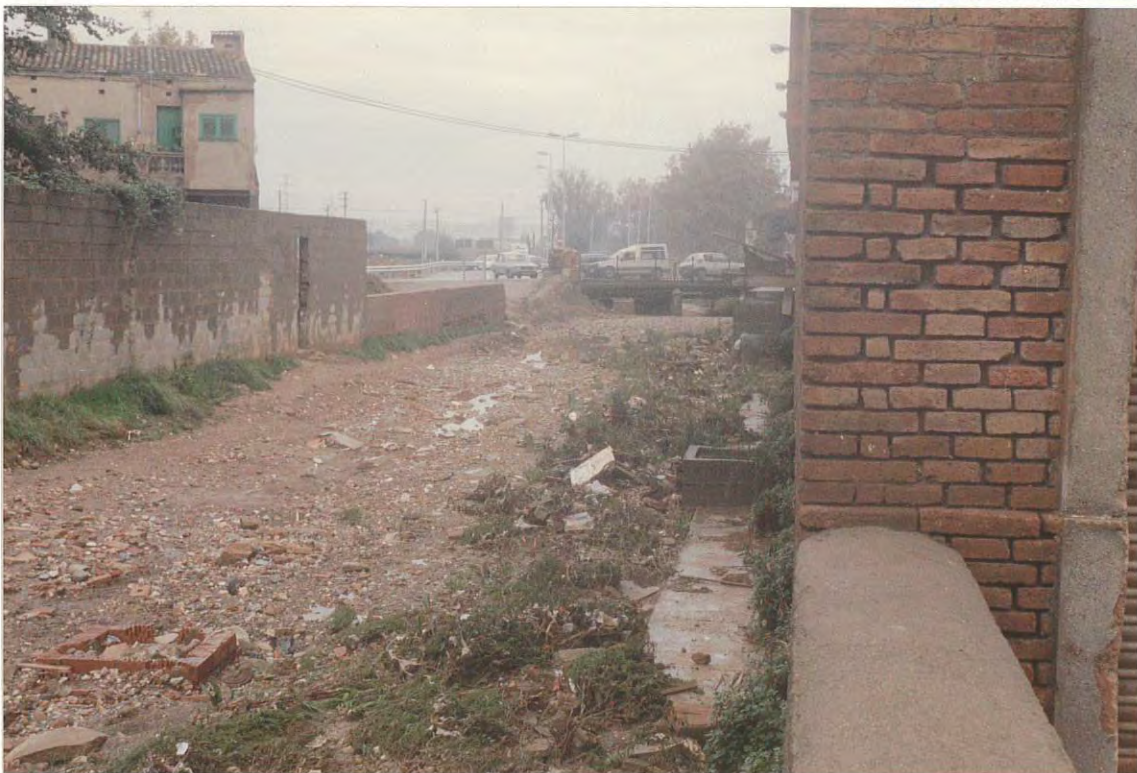
Figura 1. Cauce de la riera Bertrán, aguas arriba del cruce bajo el puente de la carretera BV-2002.
