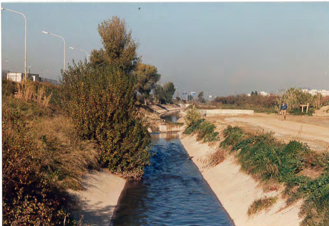
Figura 4. Canal de desagüe paralelo a la autopista A-2, a su cruce con el Rec Vell. La sección aguas arriba es más ancha y profunda que la de aguas abajo.
