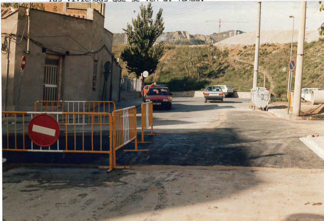
Figura 2. Cruce de las calles Molina y Masía. Obras de reparación del socavón producido por entrada en carga y posterior rotura del alcantarillado.
