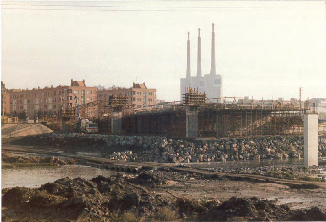
Figura 1. Escollera y terraplenado para soportar la cimbra del puente en construcción sobre el río Besós. Estos rellenos supusieron una reducción de sección próxima al 50% .
