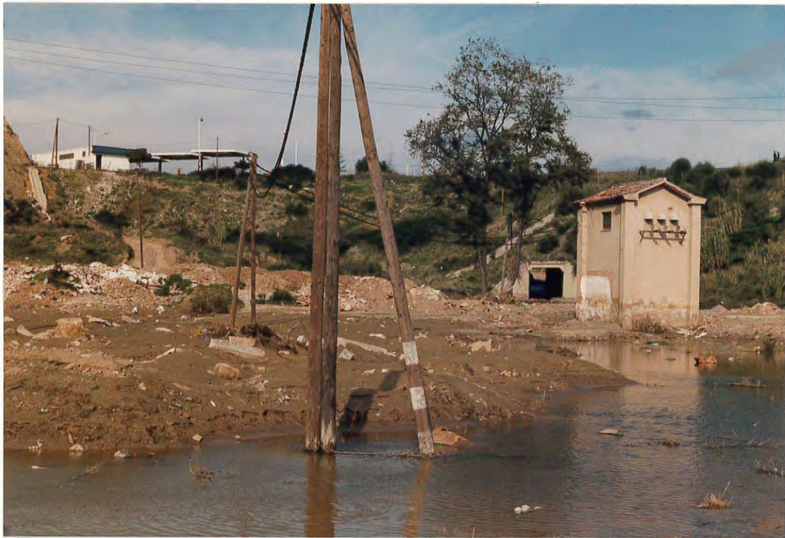
Figura 1. Colector de entrada del Torrent Tapioles a la zona del Polígono Industrial, inmediatamente antes de la primera de las industrias.
