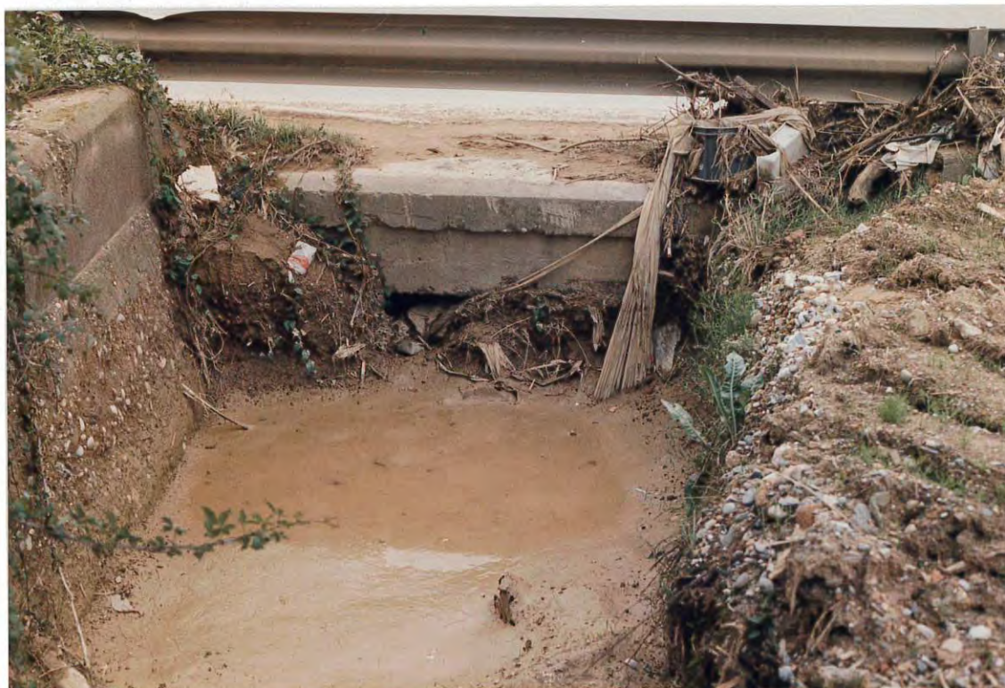
Figura 2. Vista desde aguas arriba del cruce de la riera Can Sant Tomàs bajo la carretera N-II.
