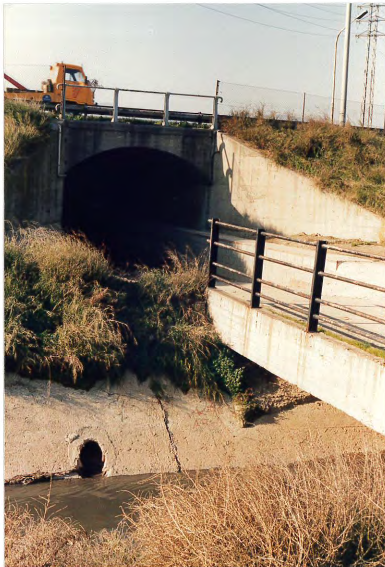
Figura 7. Vertido del drenaje de uno de los túneles al canal de desagüe paralelo a la autopista A-2.
