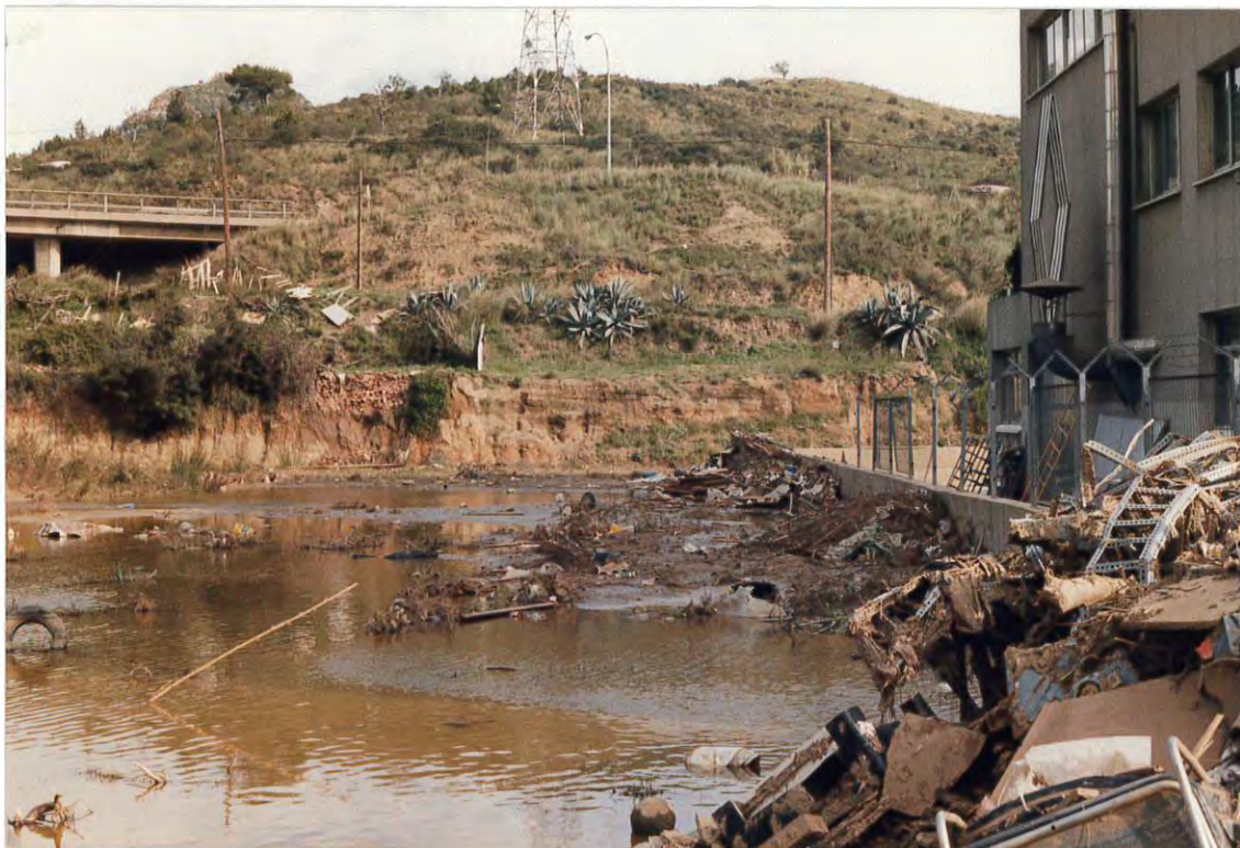
Figura 4. Arrastres y desperfectos producidos en la primera fábrica del Polígono Industrial Can Cuyás.
