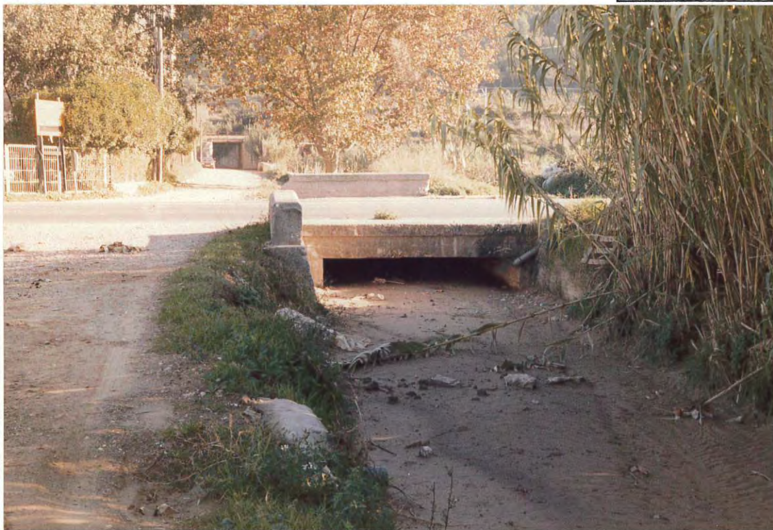
Figura 1. Cauce de la riera Can Paissa a su paso bajo la carretera N-II. Al fondo, el puente del ferrocarril.
