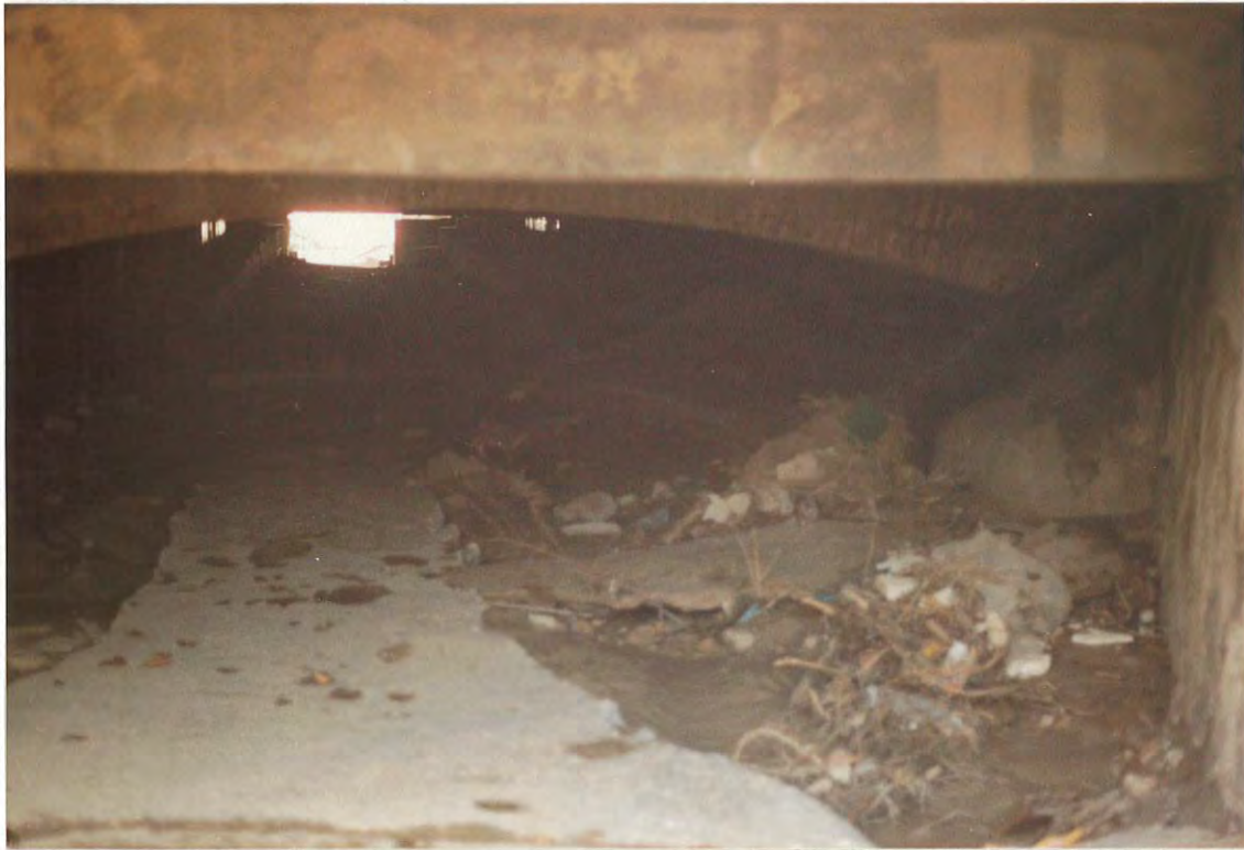
Figura 1. La Riera de Tiana a su paso bajo los puentes de la carretera N-II y del ferrocarril, donde pueden apreciarse los considerables arrastres producidos por las aguas.
