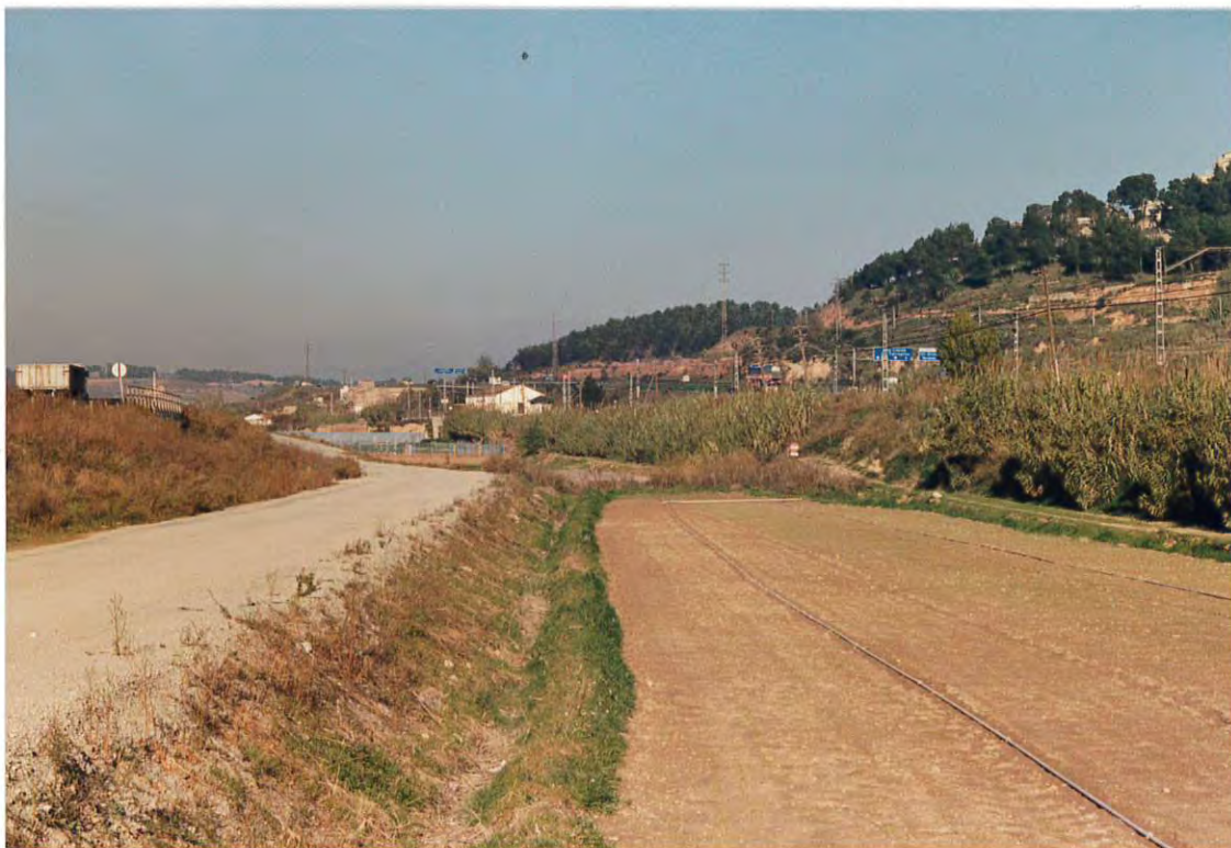
Figura 6. La insuficiente capacidad de desagüe de la riera de les Argiles provocó la inundación de los campos contiguos.
