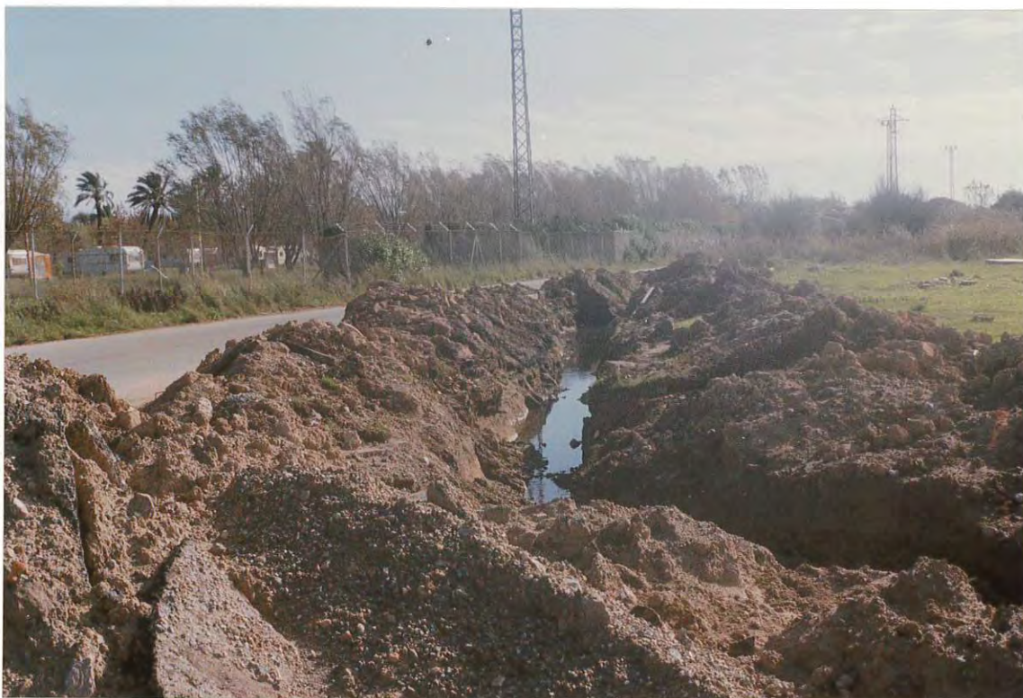
Figura 6. Zanja practicada junto a la carretera de la Aviación para drenar los campos agrícolas colindantes.
