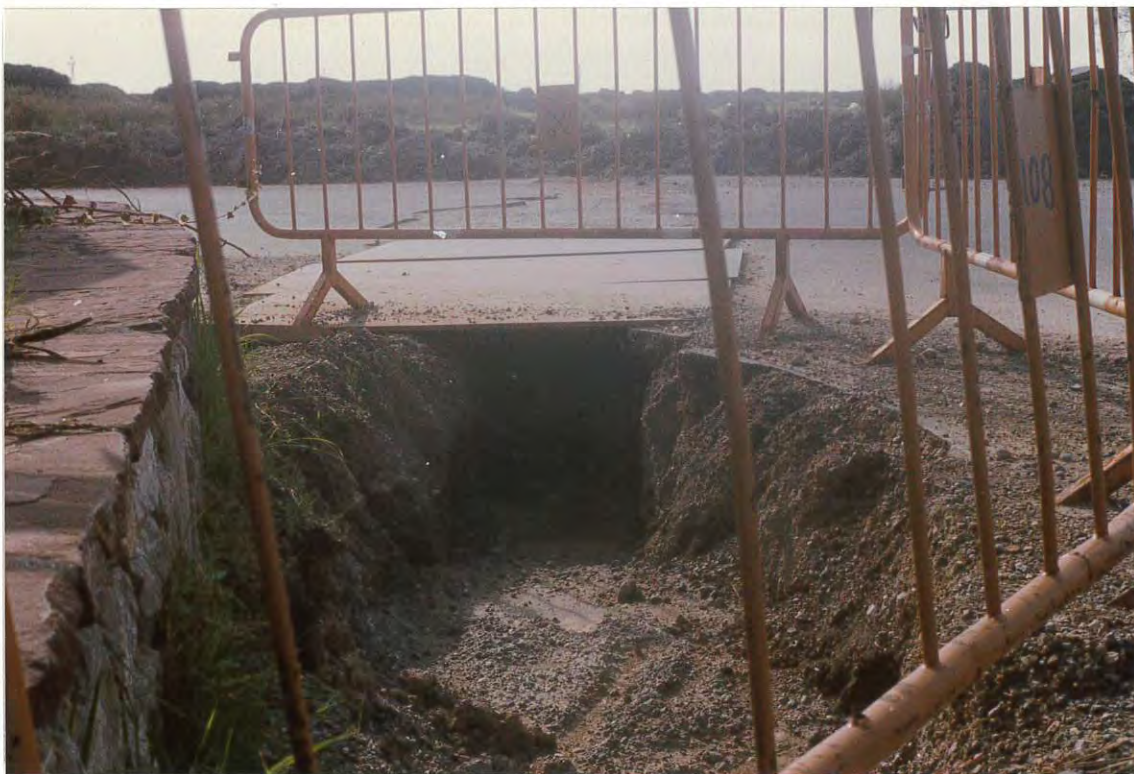
Figura 5. Zanja practicada en la carretera de la Aviación para drenar los campos agrícolas colindantes.
