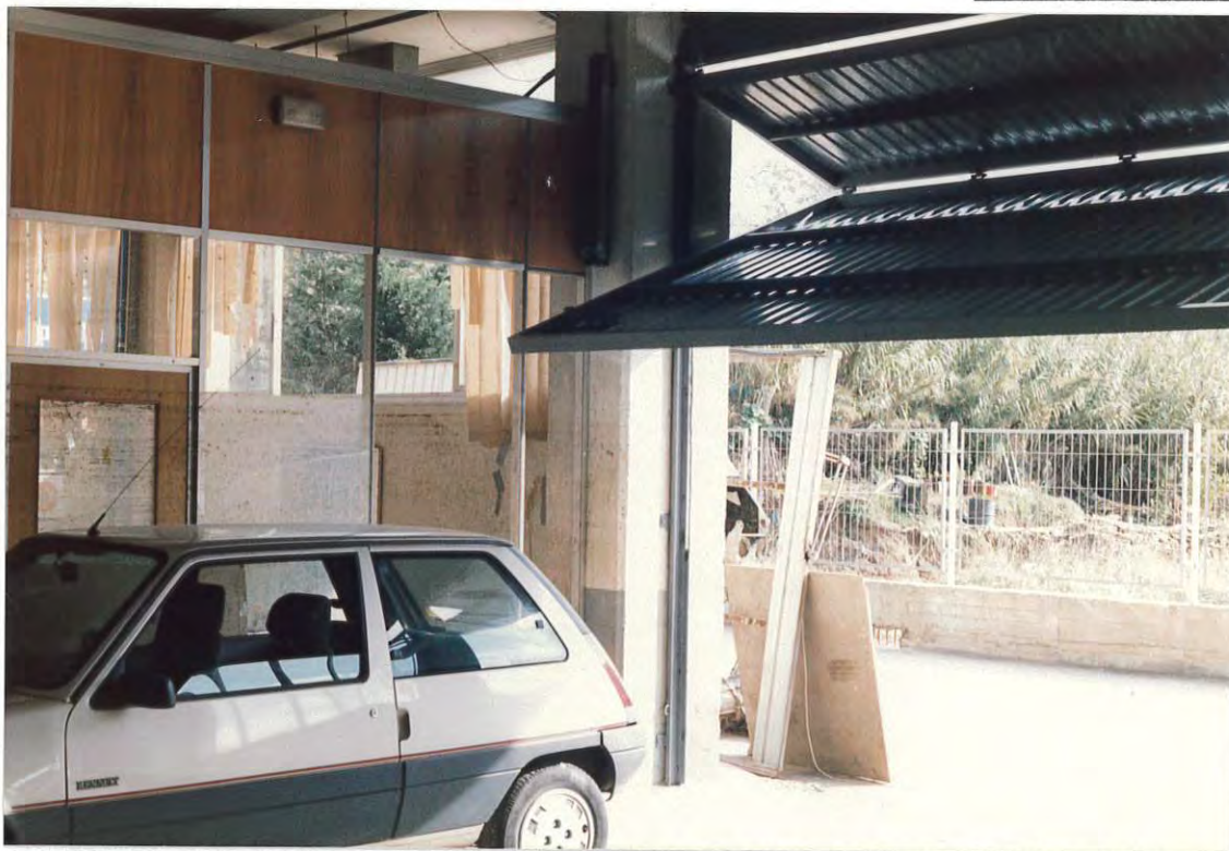
Figura 5. Nivel alcanzado por las aguas en la primera fábrica del polígono industrial: 2,0 m en su interior y 2,2 m en el exterior.
