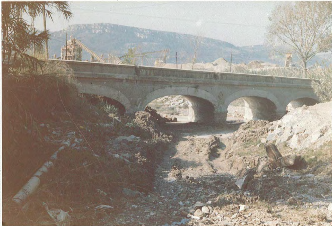
Figura 3. Taponamiento del vano izquierdo del puente de la carretera de Caldes de Montbui a Molins de Rei.
