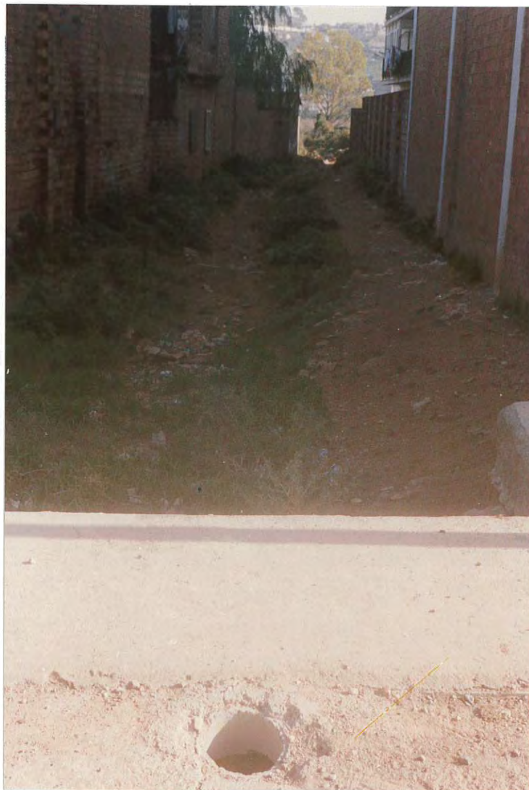
Figura 4. Ultimo tramo urbano de la riera dels Ases. En primer plano puede observarse el orificio practicado como desagüe de la calle transversal.
