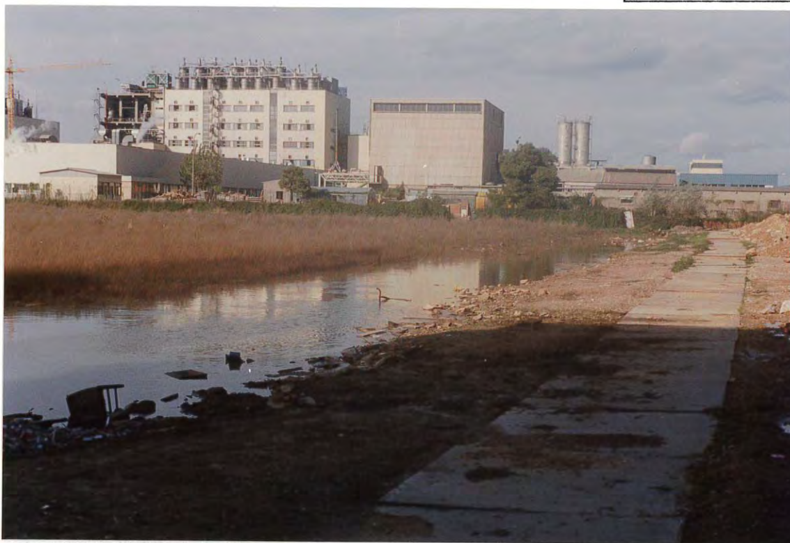
Figura 1. Campos inundados al inicio del colector del Remolar.
