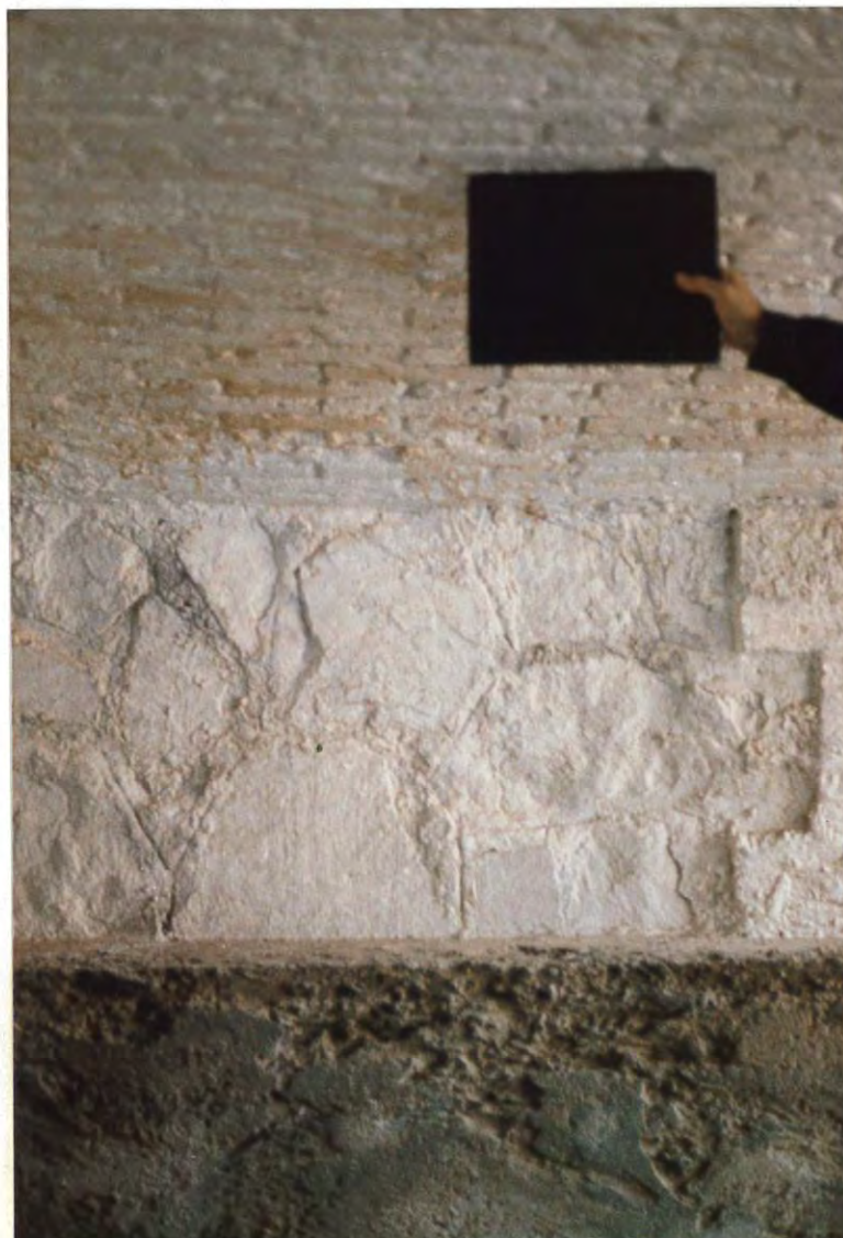
Figura 2. Altura alcanzada por las aguas, superior a 1,5 m, en los pasos de la Riera de Tiana bajo los puentes de la carretera N-II y del ferrocarril.
