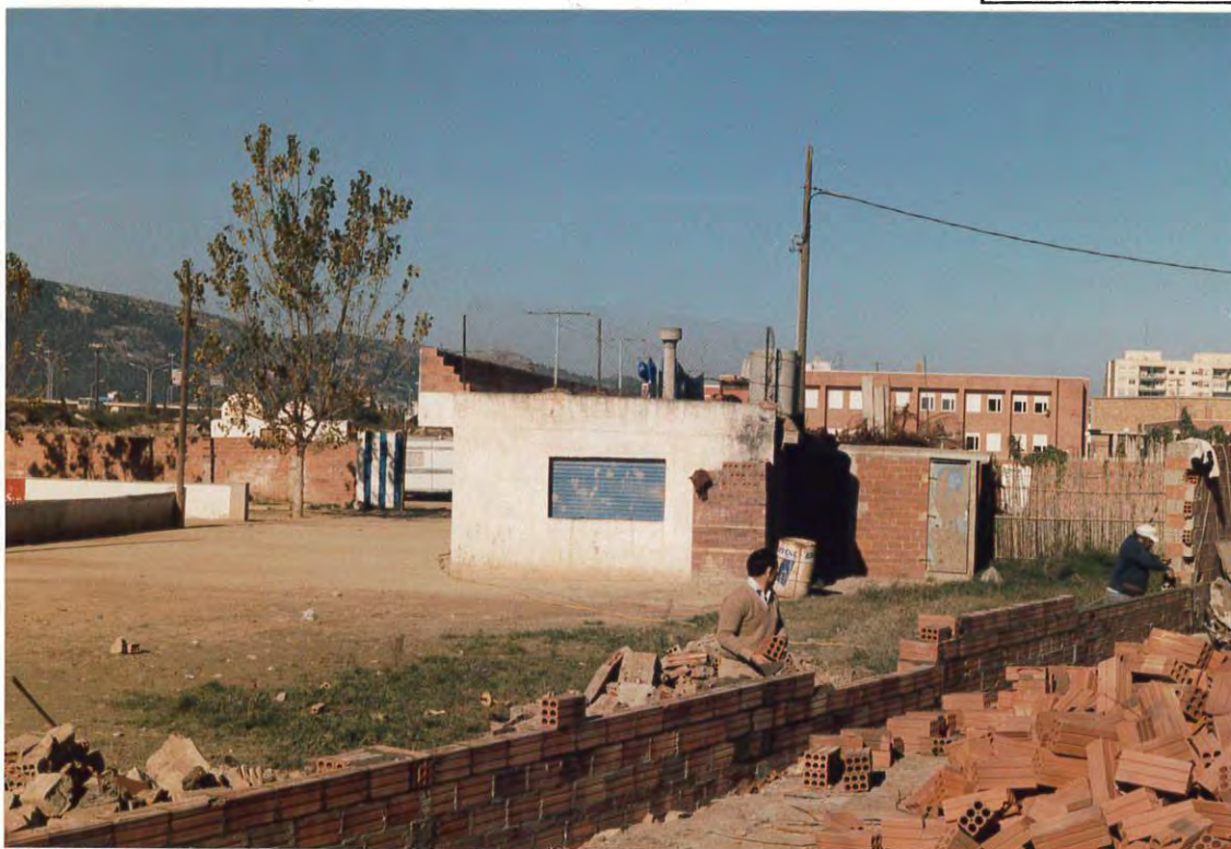
Figura 1. Trabajos de reconstrucción de la valla del campo de fútbol, situado al final de la riera Mariona.
