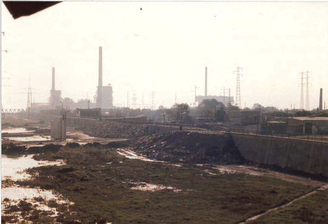
Figura 2. Escollera colocada para cubrir el hueco practicado en el hastial derecho, por donde escapó el agua del río.
