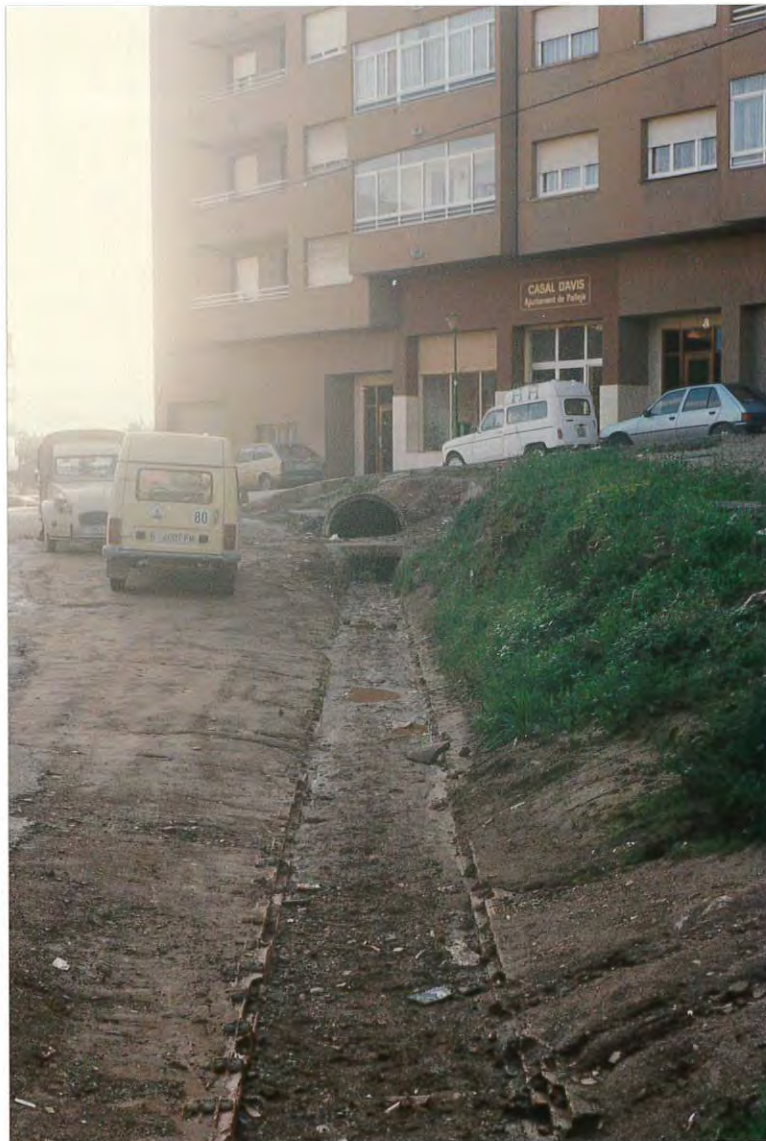
Figura 3. Detalle del desagüe de la riera dels Ases aguas abajo de su cruce con la carretera N-II, donde puede observarse la contrapendiente existente.
