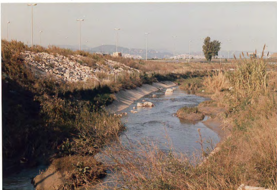
Figura 1. Vista parcial, desde aguas abajo, del canal de desagüe de la margen izquierda del río Llobregat, entre la autopista A-2 y el Cinturón Litoral.
