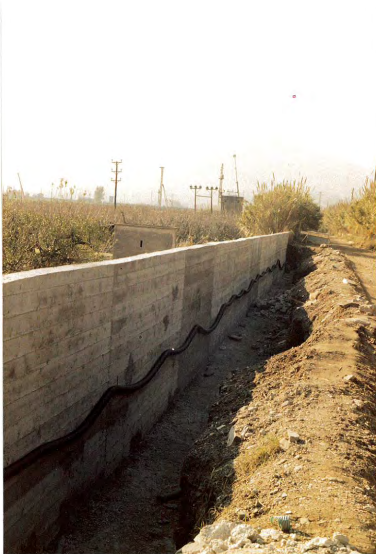
Figura 7. Muro reconstruido, para reponer el hastial izquierdo de la riera.
