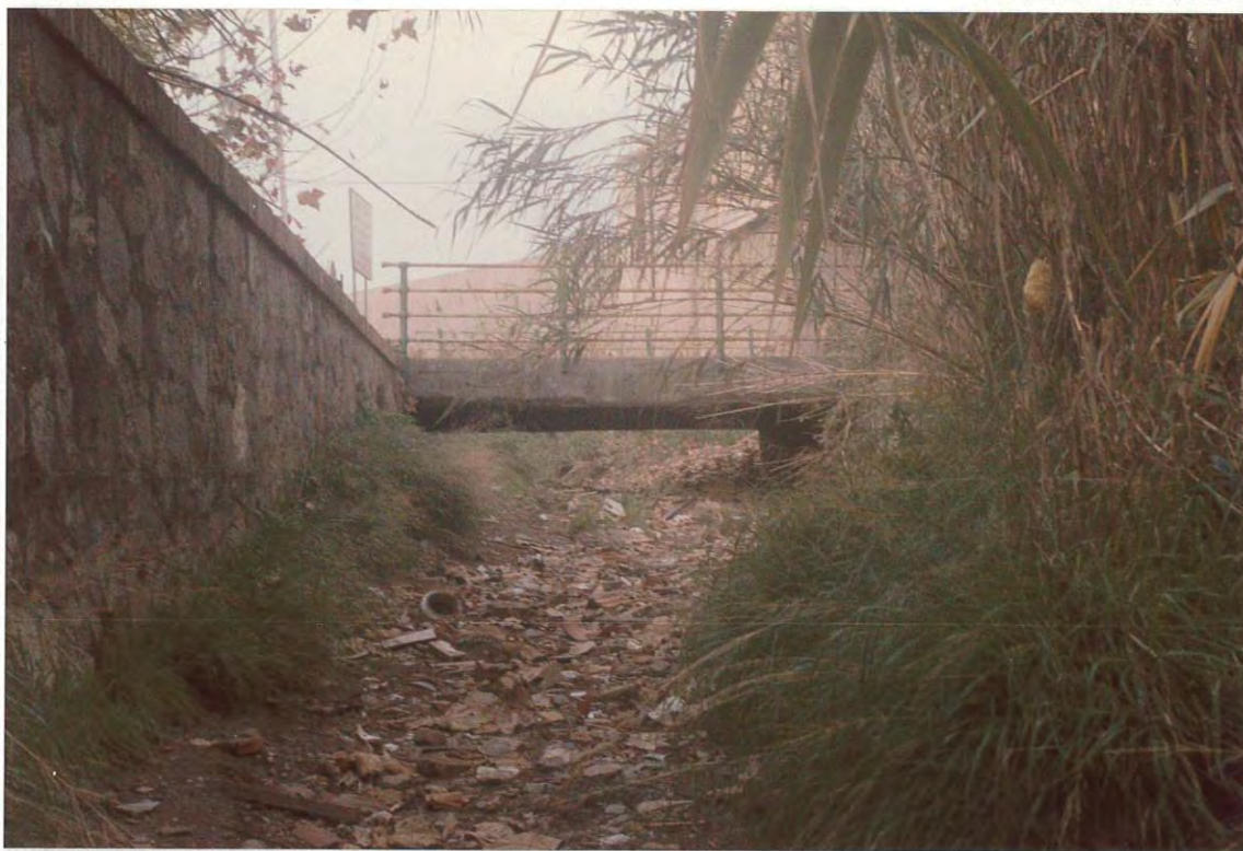
Figura 1. Cauce de la riera de Can Solé a su paso bajo el puente de la carretera BV-2002, de Sant Vicenç dels Horts a Sant Boi de Llobregat.
