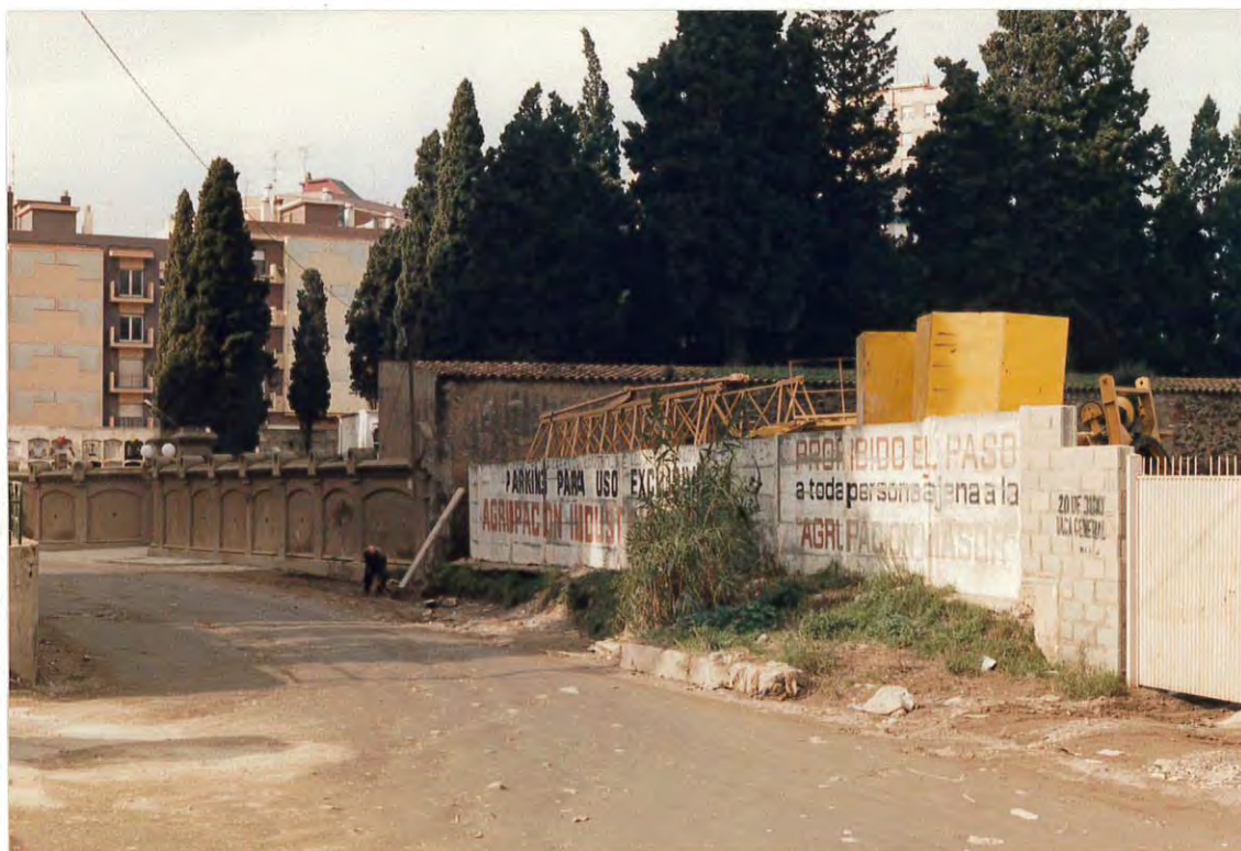
Figura 3. Alrededores del cementerio, al final de la calle de Santa Creu, donde las aguas alcanzaron 1,5 m de altura.
