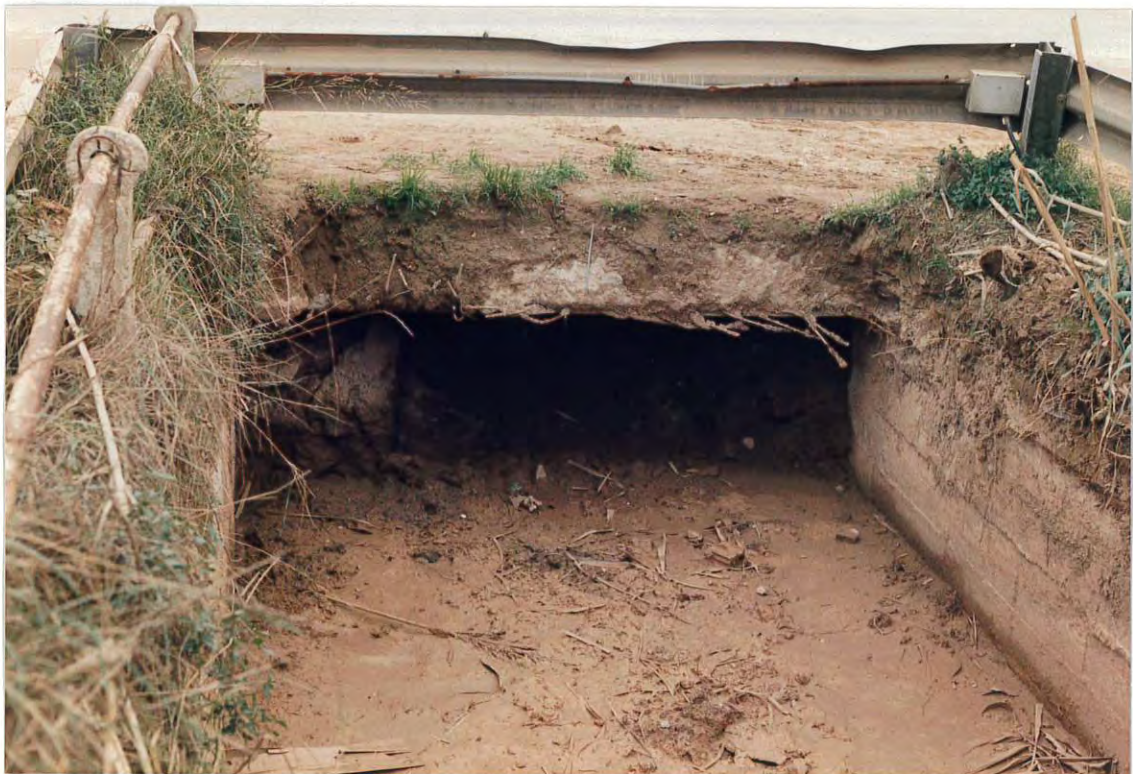
Figura 2. Cruce de la riera bajo la carretera N-II. El aterramiento del lecho y la reducción de sección impiden el desagüe de la riera con normalidad.
