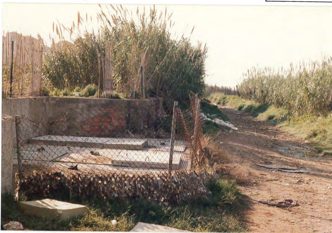
Figura 1. Tapas de registro del colector de la Font Santa. Los arrastres acumulados en las verjas de protección ilustran el nivel alcanzado por las aguas.
