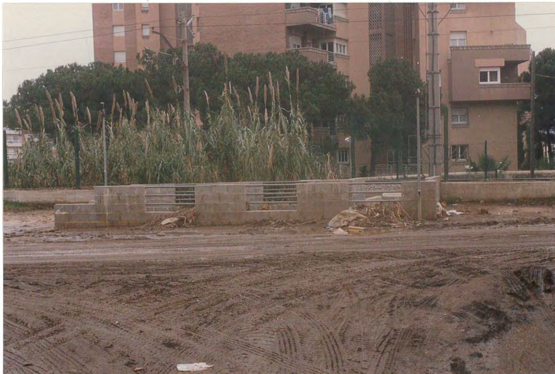
Figura 1. Vista general, desde el camino de la Font, del paso peatonal bajo la línea de los ferrocarriles de la Generalitat.
