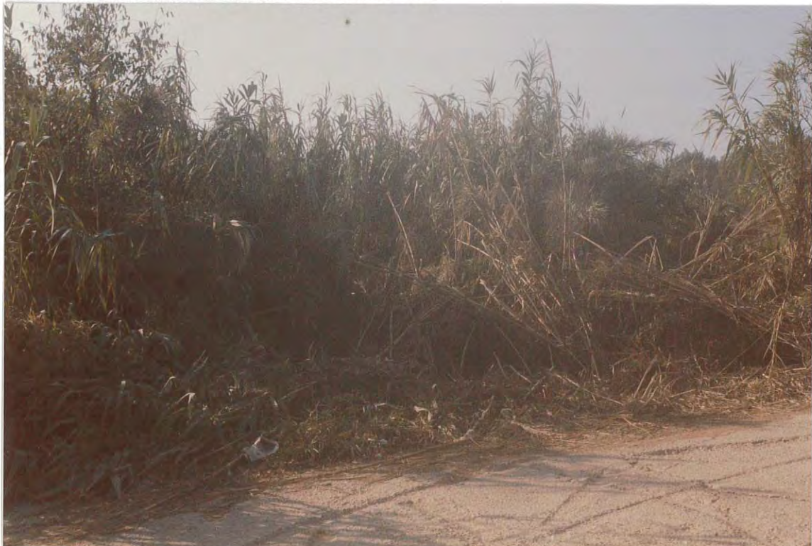
Figura 2. Estado del cauce de la riera de Mallorcaques, aguas arriba del tramo encauzado bajo el cruce con la vía férrea.
