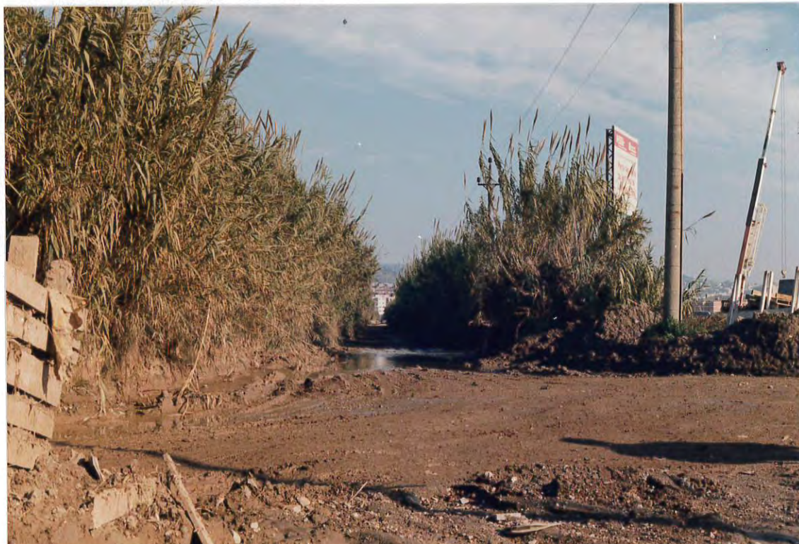
Figura 6. Vista general, desde aguas abajo, del tramo final de la riera de la Salut, en el que existe una ligera contrapendiente.
