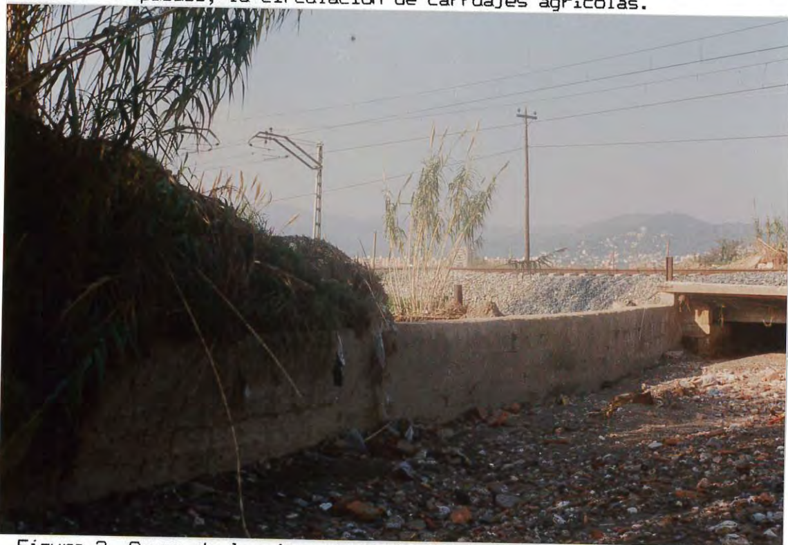
Figura 2. Cauce de la riera de Sant Climent, a su paso bajo la línea férrea Barcelona-Zaragoza, donde pueden observarse los aportes acumulados provenientes de un campo contiguo.
