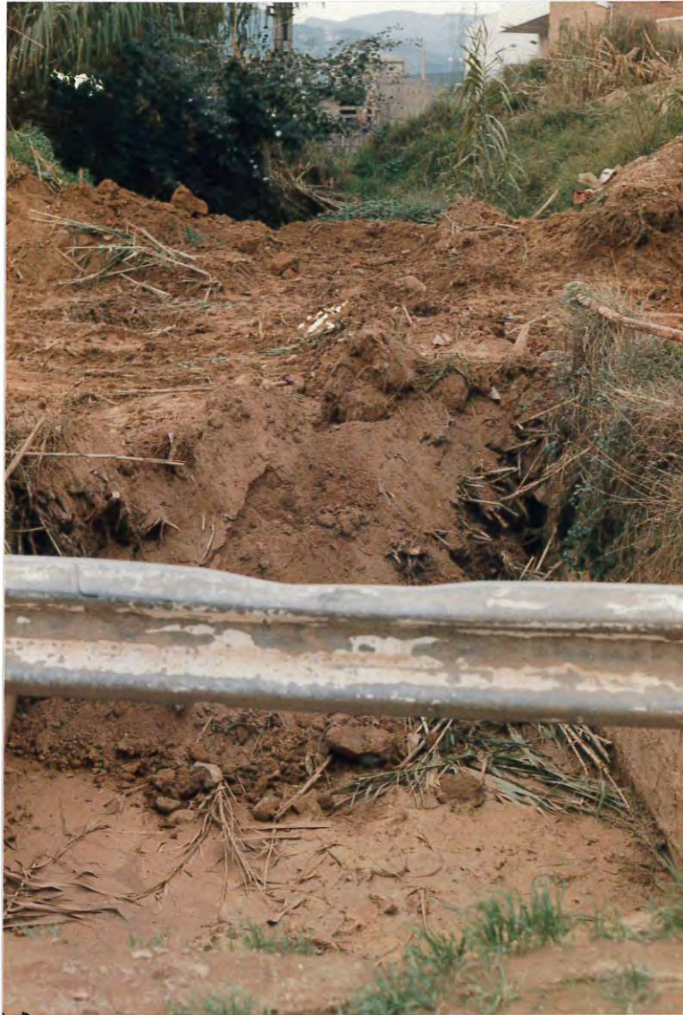
Figura 3. Vista del terraplén del acceso de vehículos que corta perpendicularmente el cauce de la riera.
