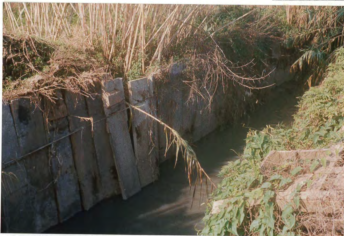
Figura 1. Estado del murete de canalización construido por los payeses en la riera de Sant Llorenç.
