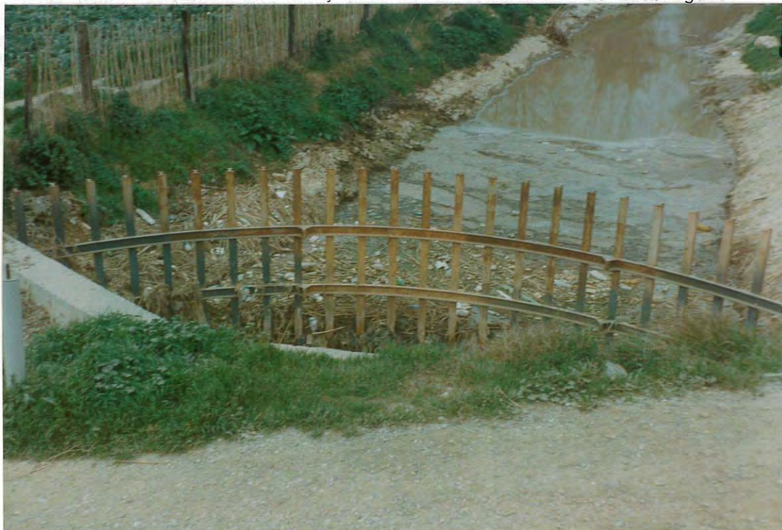
Figura 2. Reja de protección de las clapetas existentes en la desembocadura de la riera en el río Llobregat.
