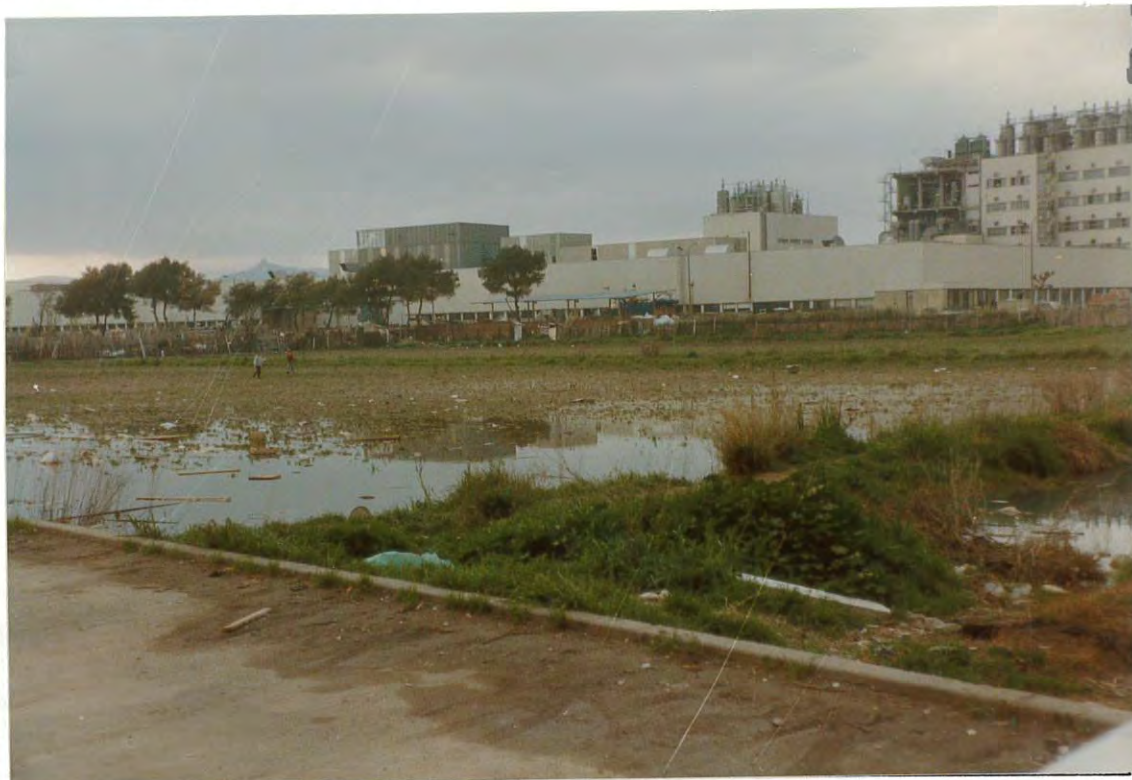
Figura 5. Inundaciones causadas por el canal de la Av. del Remolar, entre la Autovía de Castelldefels y el casco urbano.
