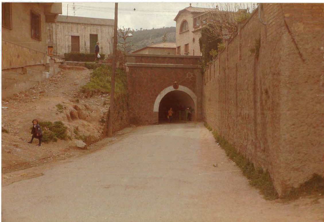
Figura 2. Puente bajo la carretera nacional N-II cuya falta de desagüe provoca la inundación de la zona.
