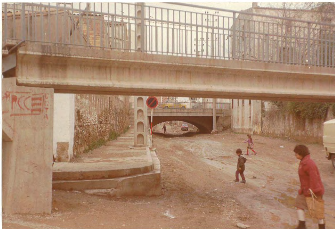
Figura 1. Puente donde quedo retenido uno de los vehículos arrastrado por las aguas.
