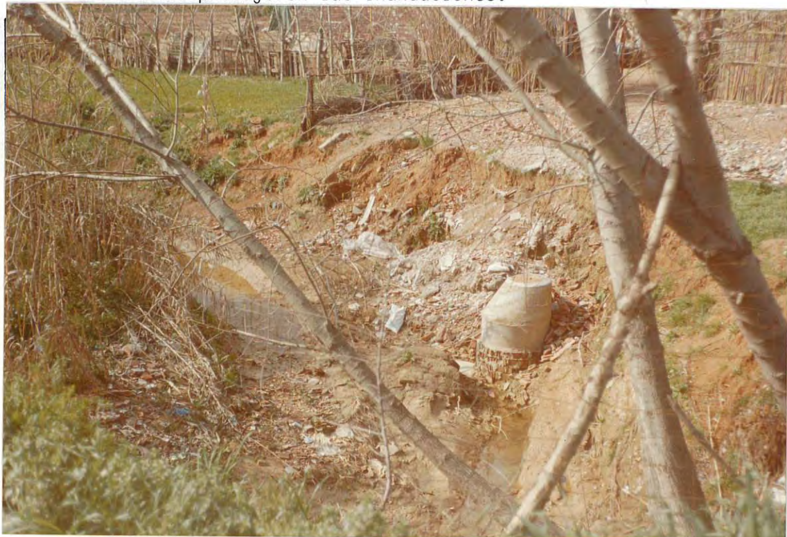
Figura 2. Vista del cauce aguas arriba del puente de la calle de San Esteban.
