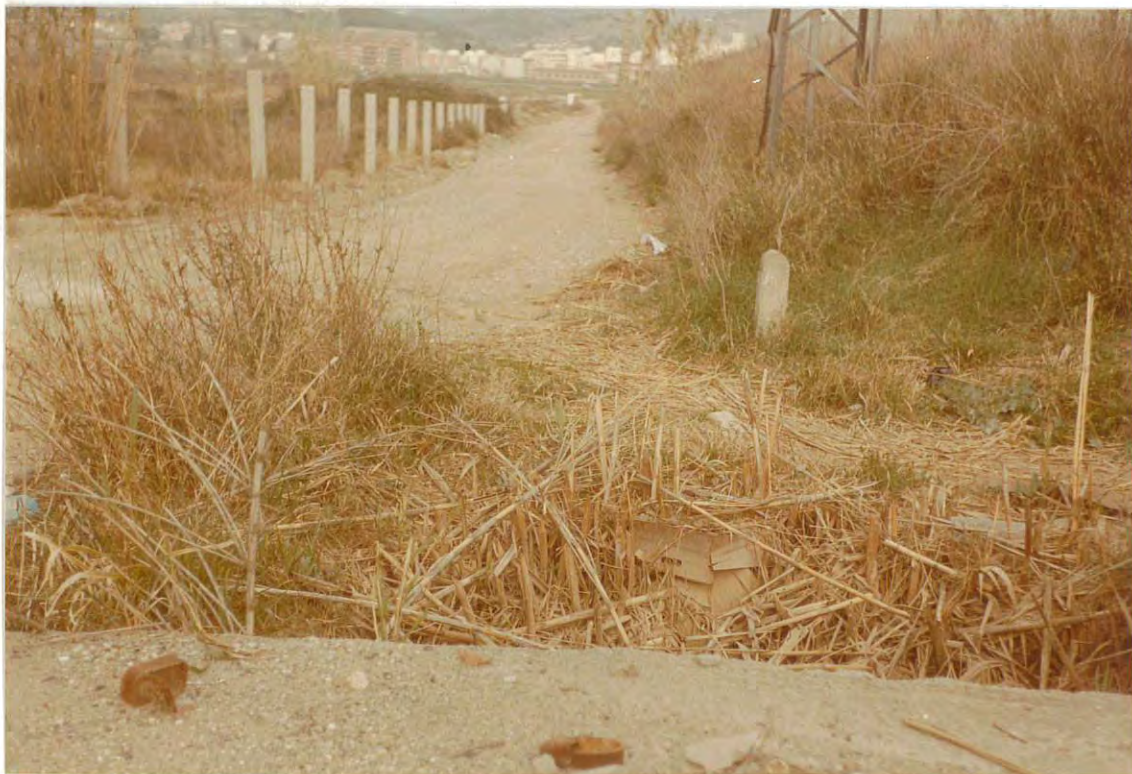
Figura 2. Terraplen construido sobre el cauce de la riera, y camino por donde discurre el agua actualmente.
