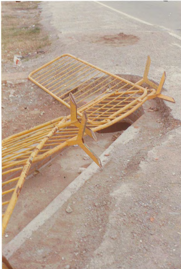
Figura 1. Desagüe provisional para remediar la inundación de las "Casas de la Seda".
