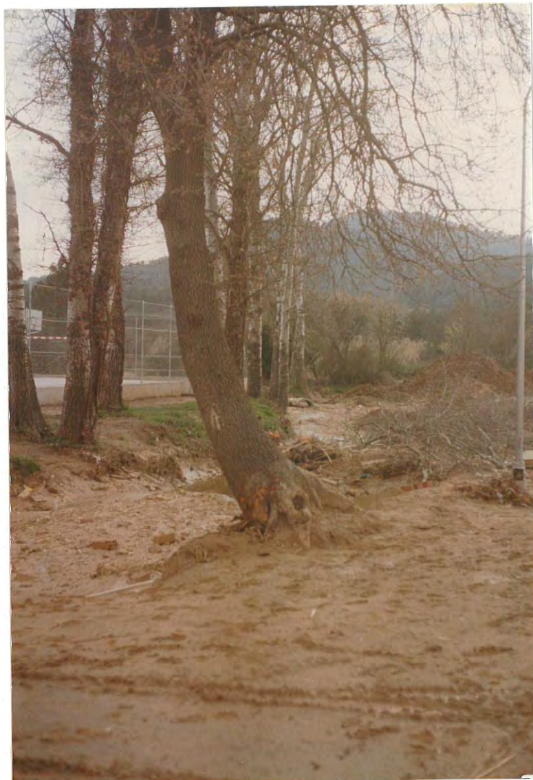
Figura 3. Erosión producida por la avenida en los márgenes de la riera.
