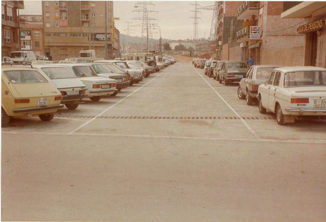
Figura 1. Rejillas sumidero instaladas recientemente en la Ronda de San Ramón.
