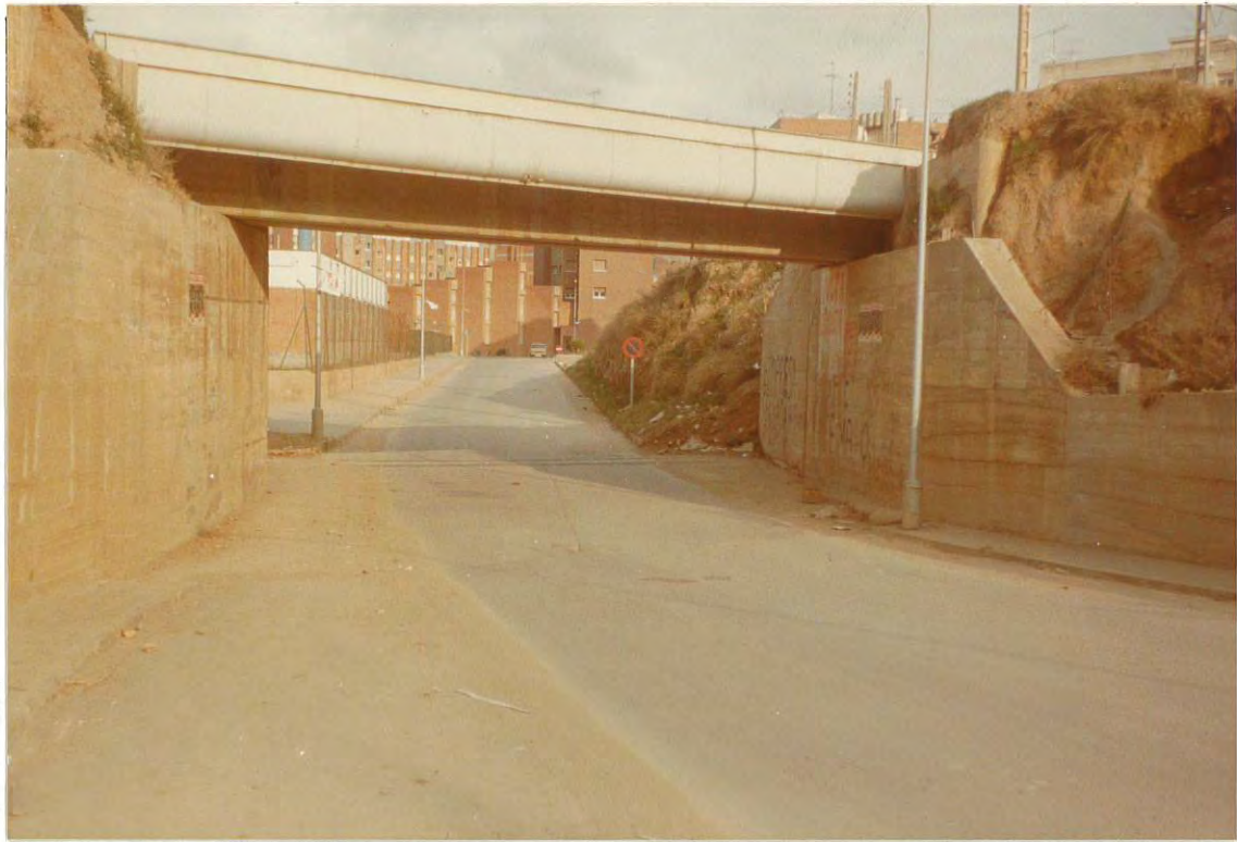
Figura 1. Vaguada de la calle Gerona y rejilla de desagüe bajo el puente del ferrocarril.
