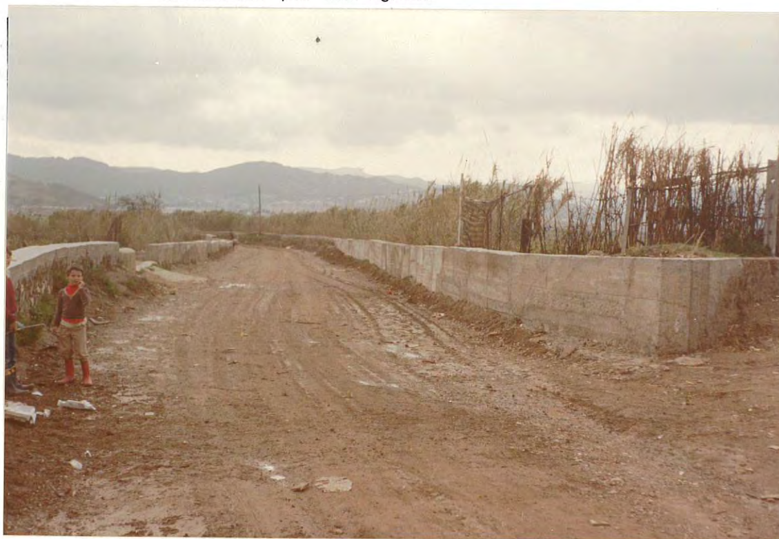
Figura 2. Reconstrucción de muro de encauzamiento aguas abajo del casco urbano.
