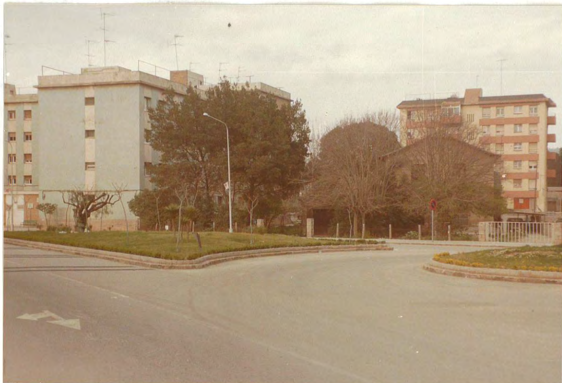
Figura 2. Viviendas afectadas en la zona inferior de la calle Barcelona.
