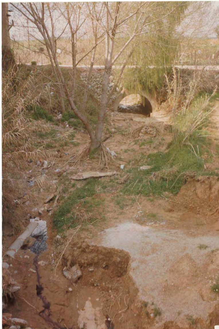
Figura 3. Cauce de la riera aguas arriba de la calle de San Esteban.
