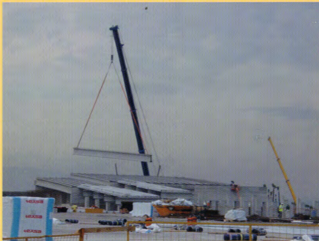
Montaje de más de 12.000 m de vigas
