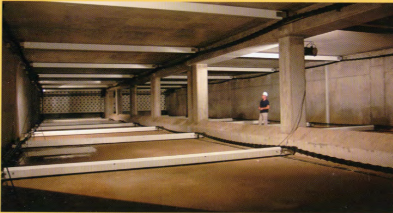
16 decantadores de 2 pisos con 3.000 ml de cadenas de plástico
