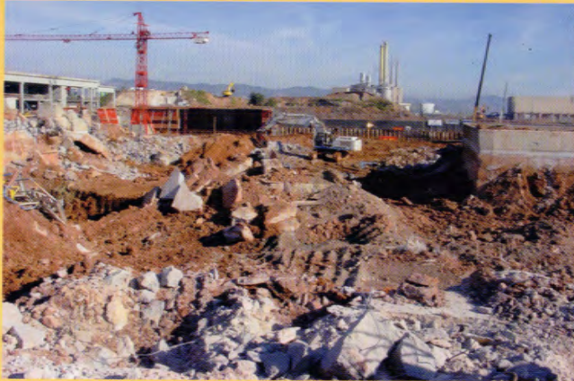
Demolición de más 60.000 m 3 de estructuras de hormigón
