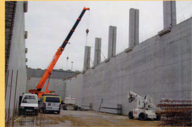
Montaje de más de 800 pilares prefabricados
