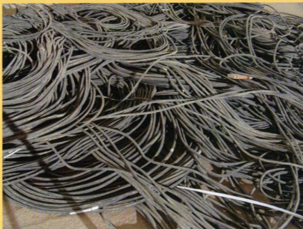
180 Km. de cable eléctrico montado
