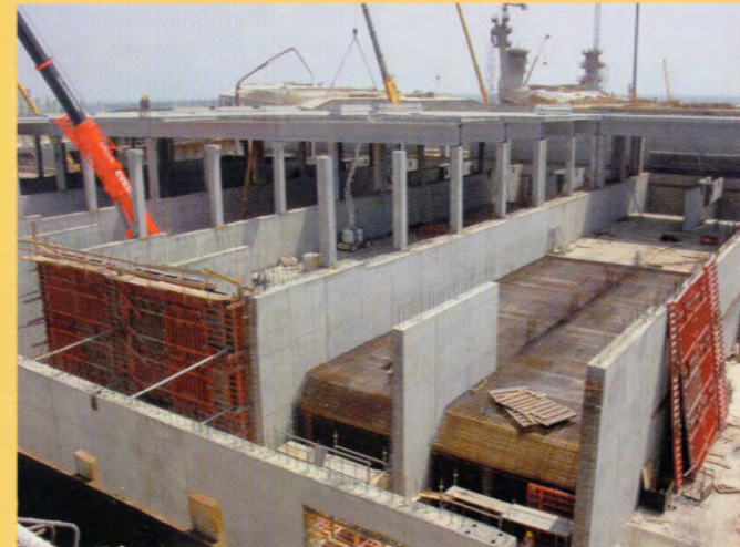
Montaje de más de 100.000 m 2 de placas pretensadas
