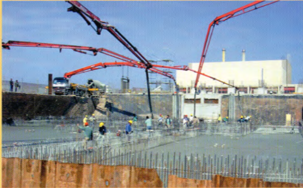
Colocación de más de 120.000 m 3 de hormigón
