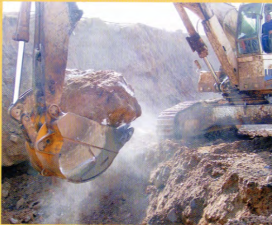
Excavación de más de 400.000 m 3 de tierras
