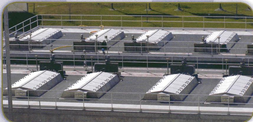
HYDROTECH Discfilter son equipos robustos y fiables, cuyas características de operatividad y rendimiento permiten su empleo en regeneración de aguas, tratamiento de aguas pluviales, pretratamiento de agua potable, así como tratamiento para agua de servicio y proceso industrial.
