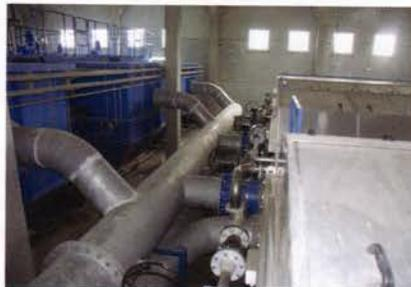
Un total de 5 (1 por línea + 1 de reserva) bombas de tornillo de la marca PCM de caudal 100-400 l/h a 4 bar de presión, dosifican una caudal máximo por línea de 290 l/h de floculante. Esta dosificación se realiza con control de flujo proporcional al caudal de entrada.
