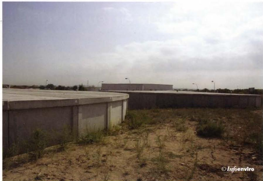
30,91 m y 7,95 m de altura cada uno. Las válvulas de salida en depósito se alojan en el edificio del bombeo de Rejas, mientras que las de llegada se disponen en una arqueta exenta desde la que se distribuye agua a ambos depósitos.
