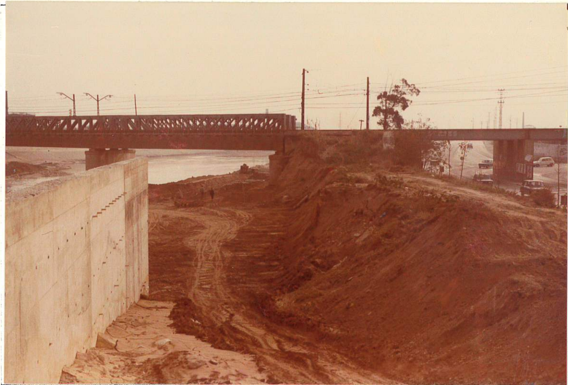
Fotografía 10. Obras de Encauzamiento de la Margen Derecha, Aguas Arriba del Puente de RENFE, y Paso Inferior de la Carretera de Acceso a la Zona Franca.
