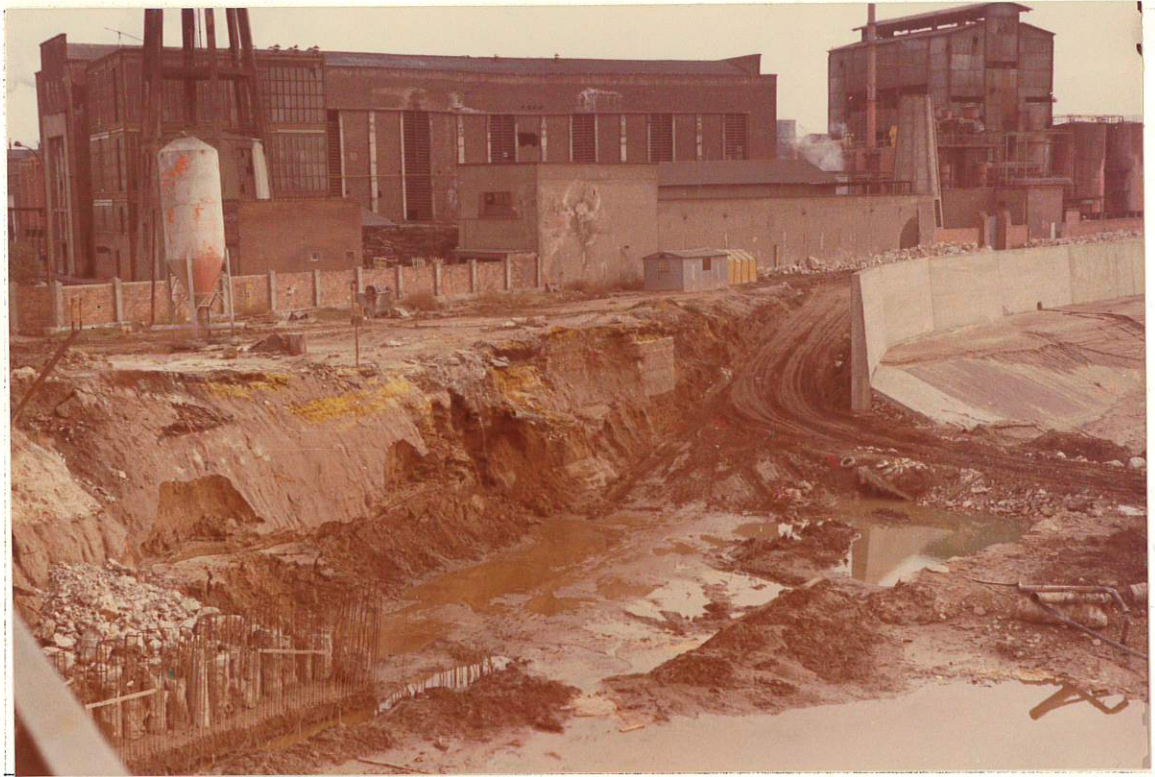
Fotografía 17. Muro de Encauzamiento de la Margen Izquierda, Aguas Abajo del Puente de RENFE.
