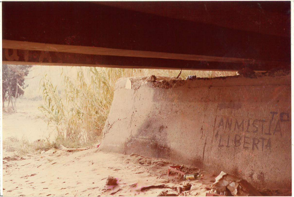
Fotografía 19. Estribo Accidental Derecho del Puente de Mercabarna, en la Carretera de Acceso a la Zona Franca.
