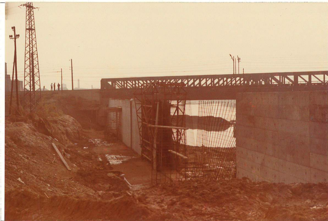
Fotografía 14. Muro de Encauzamiento de la Margen Izquierda, Aguas Arriba del Puente de RENFE.
