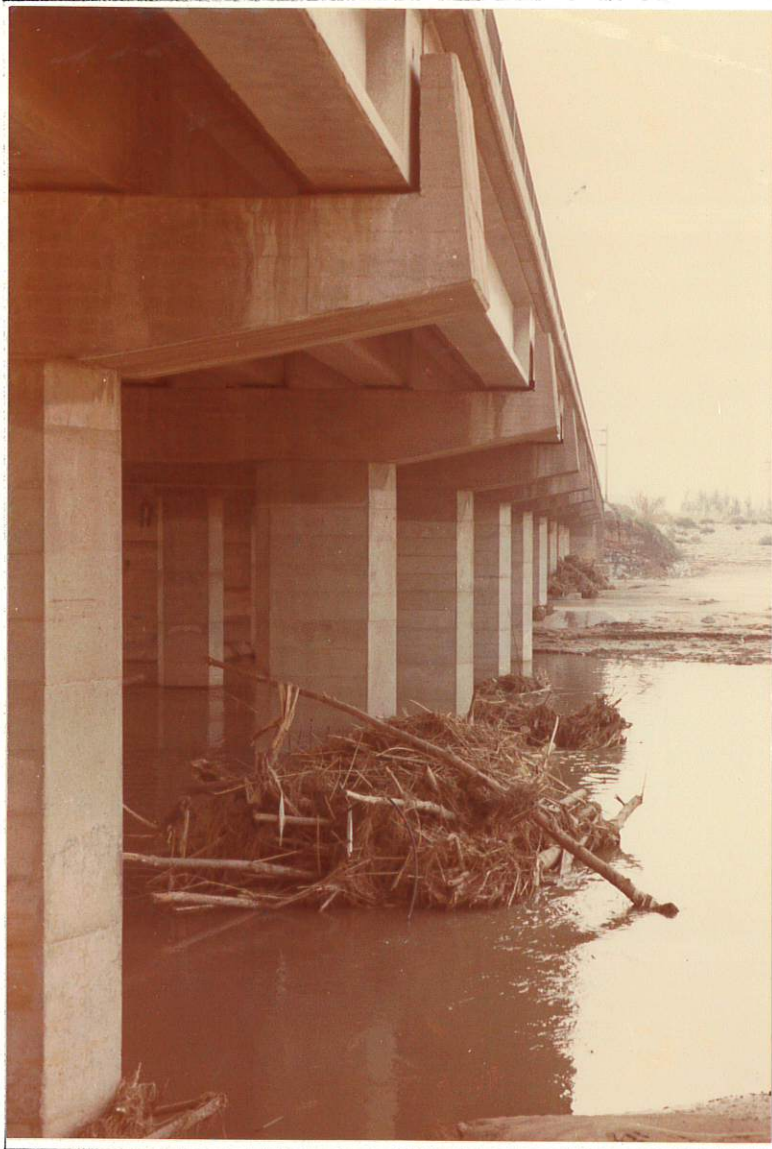
Fotografía 7. Puente Nuevo de la Carretera C-246, Autovía de Castelldefels.
