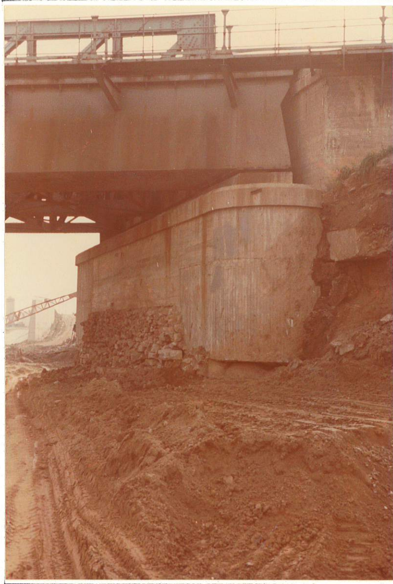
Fotografía 13. Estribo Derecho del Puente de RENFE.
