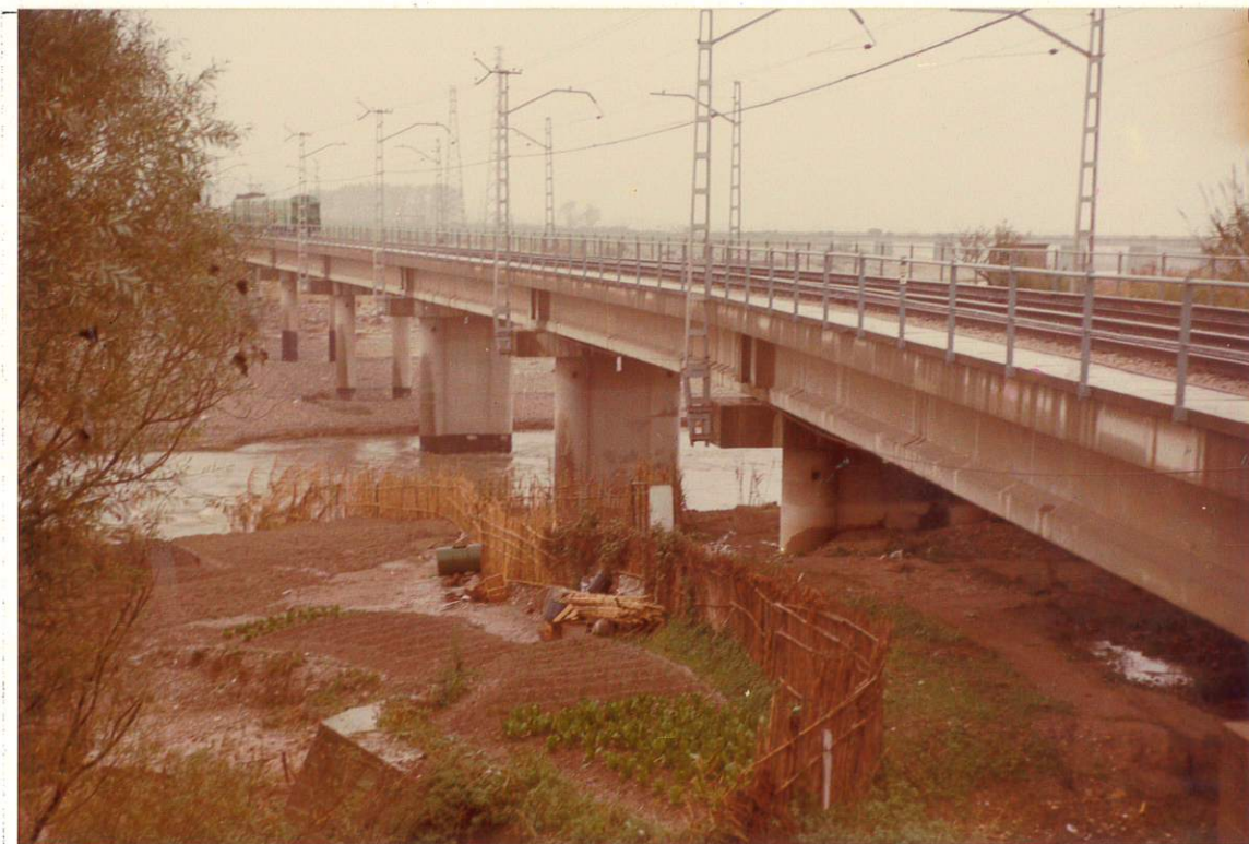
Fotografía 3. Puente de los Ferrocarriles de la Generalitat, Estribo Derecho.
