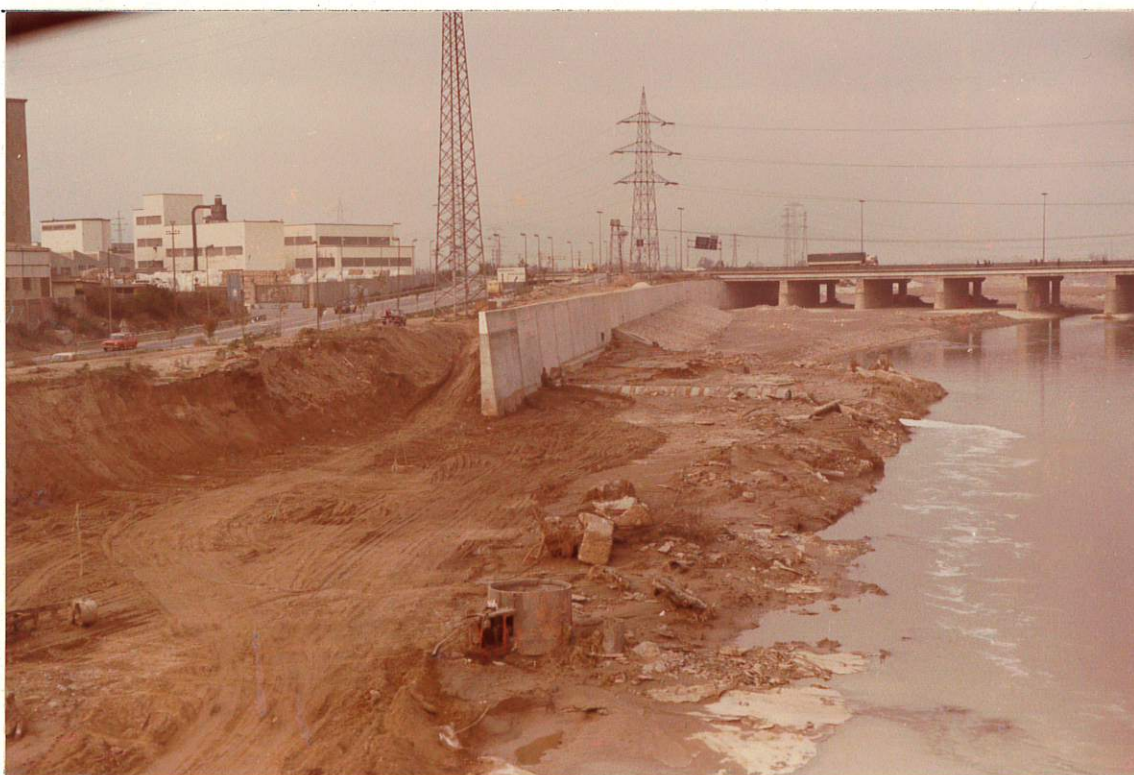
Fotografía 9. Estado de las Obras de Encauzamiento de la Margen Derecha, Aguas Arriba del Puente de RENFE.
