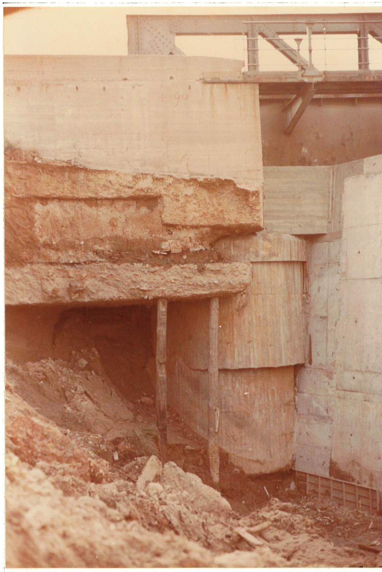
Fotografía 16. Estribo Izquierdo del Puente de RENFE, y Muro de Encauzamiento Sobre la Coronación de la Pila.
