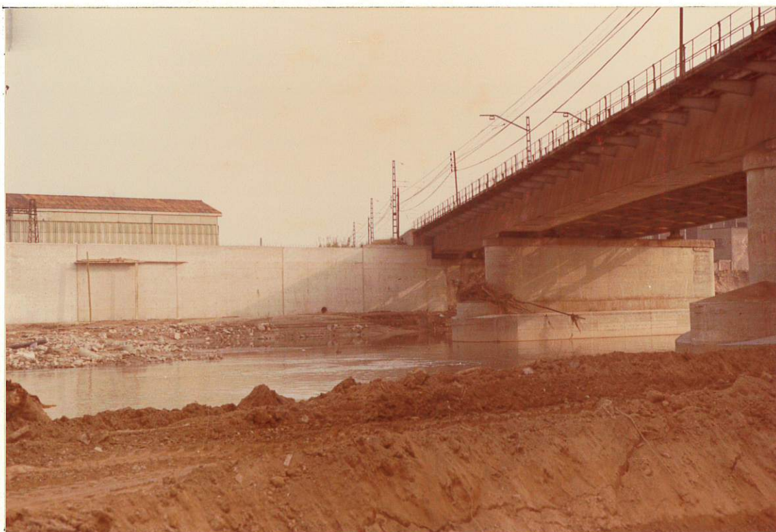
Fotografía 15. Muro de Encauzamiento de la Margen Izquierda, Aguas Arriba del Puente de RENFE.
