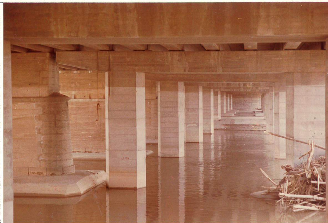
Fotografía 8. Puentes de la Carretera C-246, Autovía de Castelldefels.
