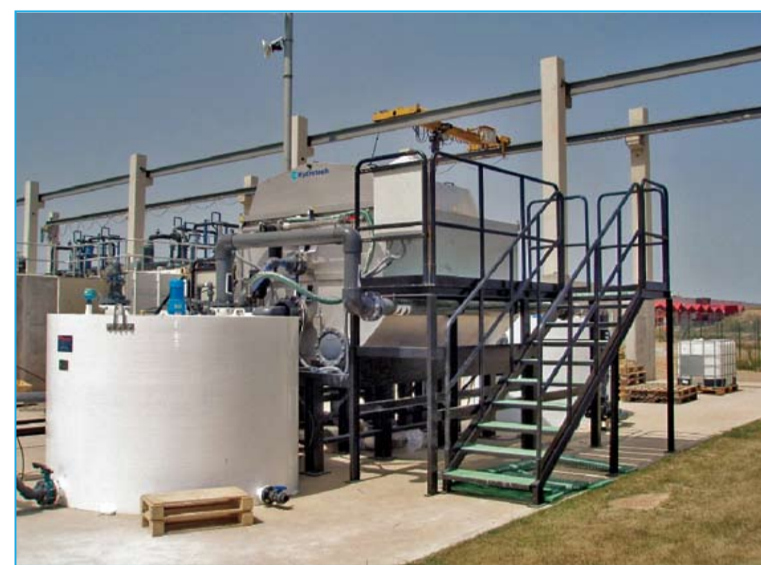
Proyecto de demostración con el Hydrotech Discfilter HSF 2204/1 en la planta de regeneración de agua de El Baix Llobregat.
