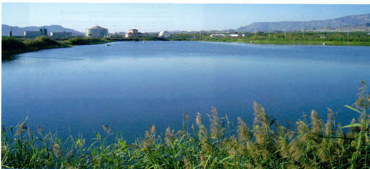
Lagunas de Tratamiento de Aguas Residuales de Molina de Segura - Campotéjar.
