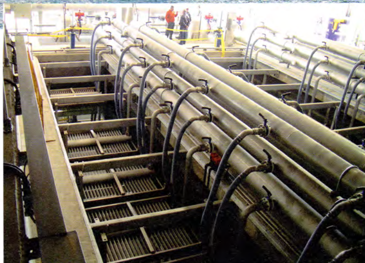
[8] Reactores Biológicos de Membranas de San Pedro del Pinatar.
