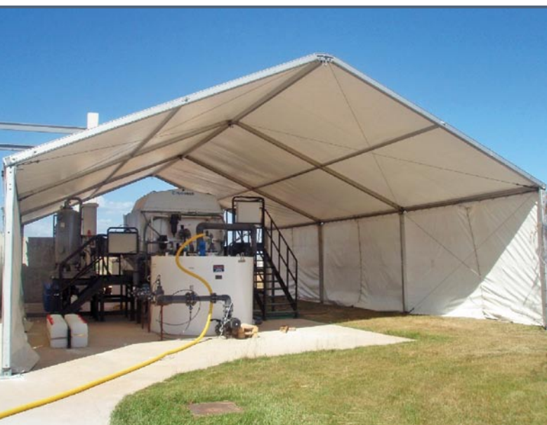
Figura 4. Vista de la planta de demostración en la planta de regeneración de agua de la EDAR Baix Llobregat.
