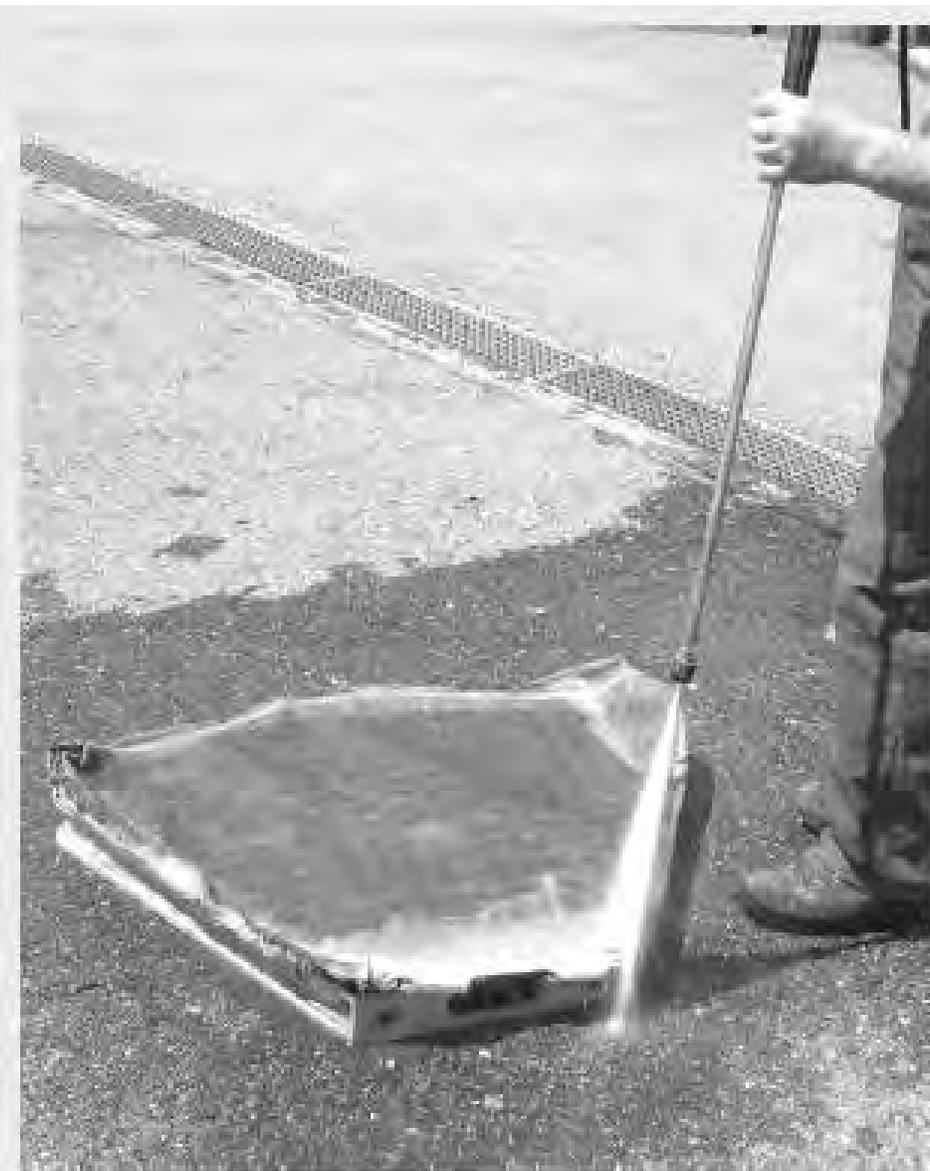
**Dibujo 6 Lavado del Textil filtrante por la cara interna**
