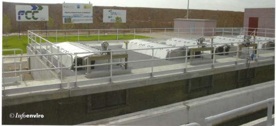
diseño compacto, lo que le convierte en un sistema muy apropiado para el pulido de efluentes donde se requiera un ahorro de espacio, con pequeño tamaño de paso y alta superficie de filtración.
