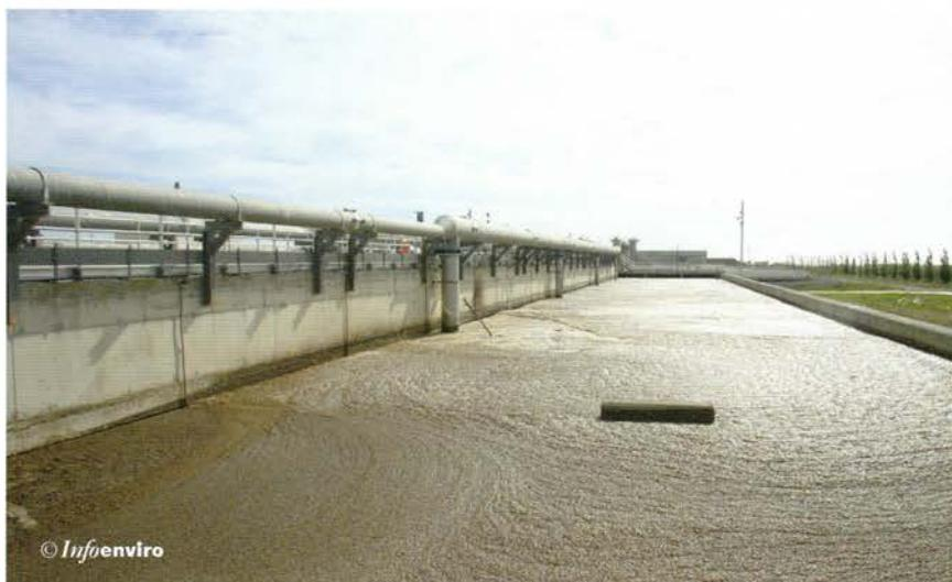
tro del decantador. El fango pasa de estos tubos a un canal y de este a la zona central del decantador de donde se extrae para su recirculación y bombeo a espesamiento.
