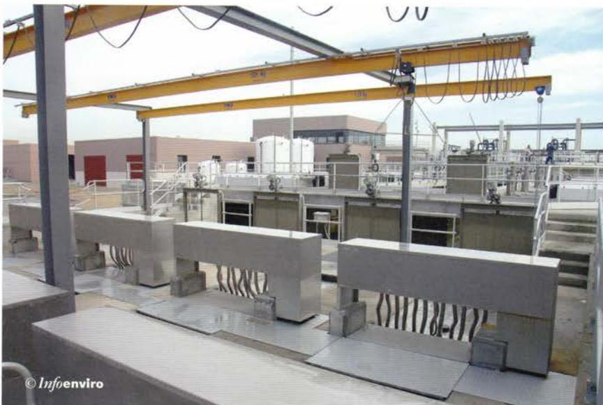
El sistema de control, basado en microprocesador, monitoriza el equipo completo de desinfección, controlando el encendido de las bancadas y la potencia de las lámparas en función del caudal.
