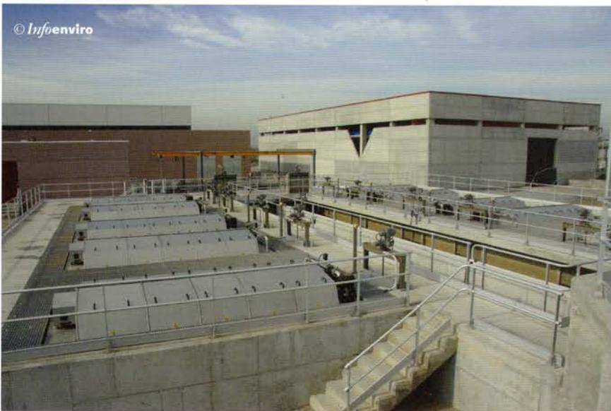
Después de la floculación el agua entra en el decantador lamelar. Los flóculos sedimentan rápidamente puesto que la microarena aumenta considerablemente el peso de los flóculos en comparación con otros procesos de precipitación. Esto implica que la velocidad superficial en el separador lamelar puede ser de 30-80 veces superior que la de las plantas de precipitación química convencional. El agua tratada pasa a través de las lamelas y abandona el proceso ACTIFLO® por los canales de salida.
