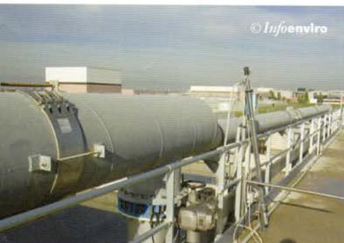
Uniones flexibles para la conexión de tuberías suministradas por Arpol
